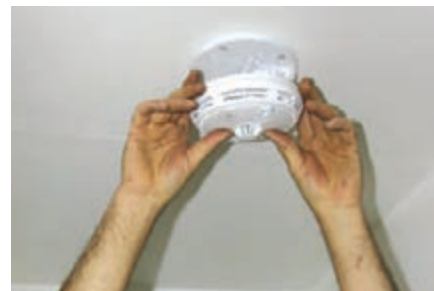
شکل ۱-۱۵ قرار دادن یک نوع آشکارساز روی پایه
