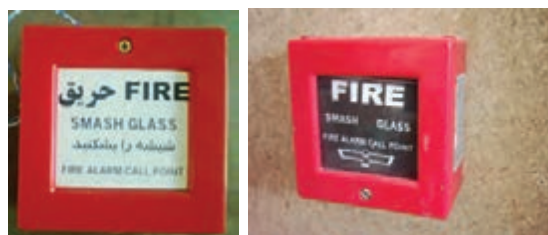
شکل ۱-۲۱ دو نمونه شستی اعلام حریق شیشه‌ای
