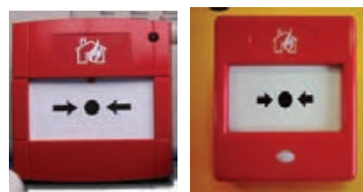
شکل ۱-۲۲ دو نمونه شستی اعلام
