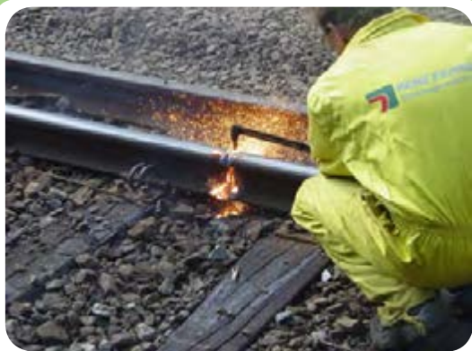
استفاده از برشکاری حرارتی جهت بریدن ریل آهن
