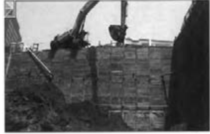
شکل ۱- ضرورت رعایت ایمنی در عملیات گودبرداری
