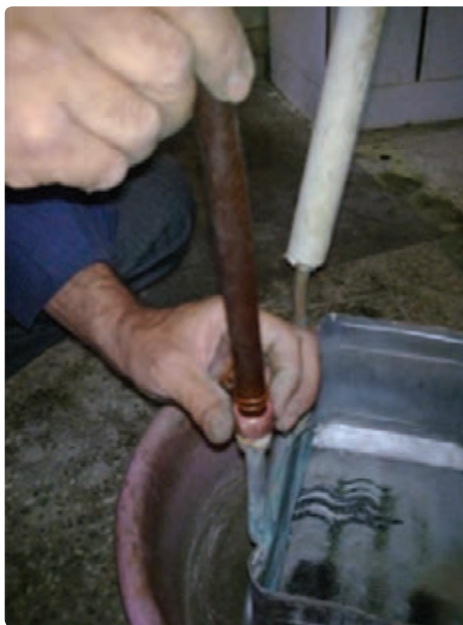
شکل ۱۶- به یک طرف مبدل شیلنگ لاستیکی و طرف دیگر لوله پلاستیکی نوع PP متصل می‌شود.
