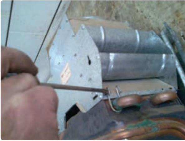
شکل ۶- جدا کردن کلاهک تعدیل از مبدل
