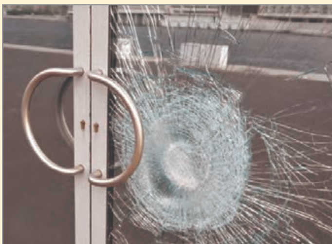
شکل ۳۹- شیشه طلقی (لمینیت) پس از شکسته شدن
