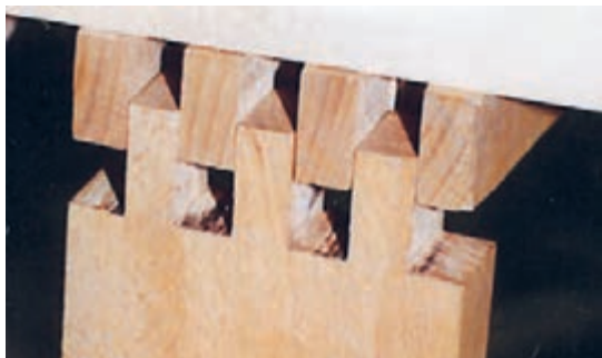
شکل ۱۲- اتصال انگشتی با تعداد زبانه فرد
