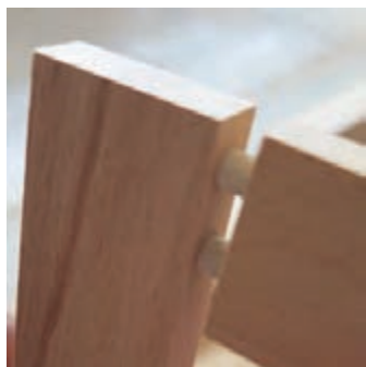
شکل ۱۱- اتصال دوبل (میخ چوبی)
