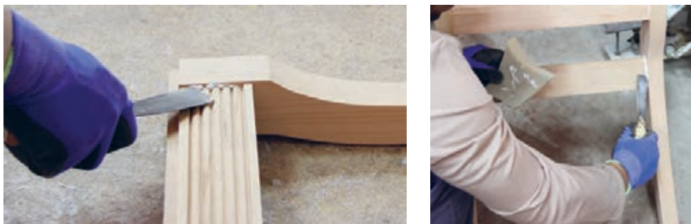
شکل ۶۷- تمیز کردن چسب اضافی با کاردک
