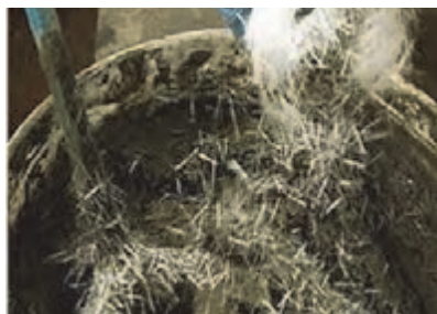
شکل ۱۸- استفاده از الیاف شیشه در مخلوط سیمان
