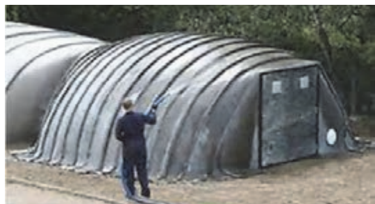
شکل ۲۸- یک نمونه از سنگرهای پارچه سیمانی شده
