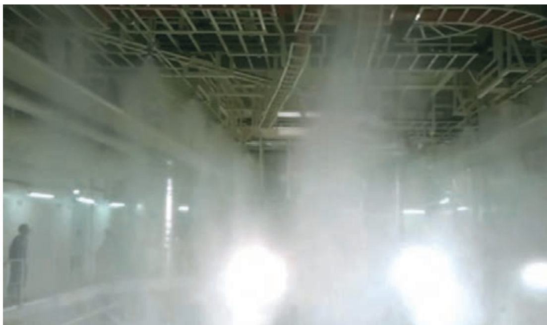
شکل ۱۶- عمل کردن حسگرها در موتورخانه یک کشتی
