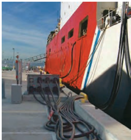
شکل ۲۵- استفاده از برق اسکله در زمان پهلوگیری شناور
