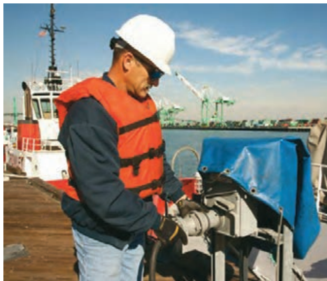
شکل ۲۵- استفاده از برق اسکله در زمان پهلوگیری شناور
