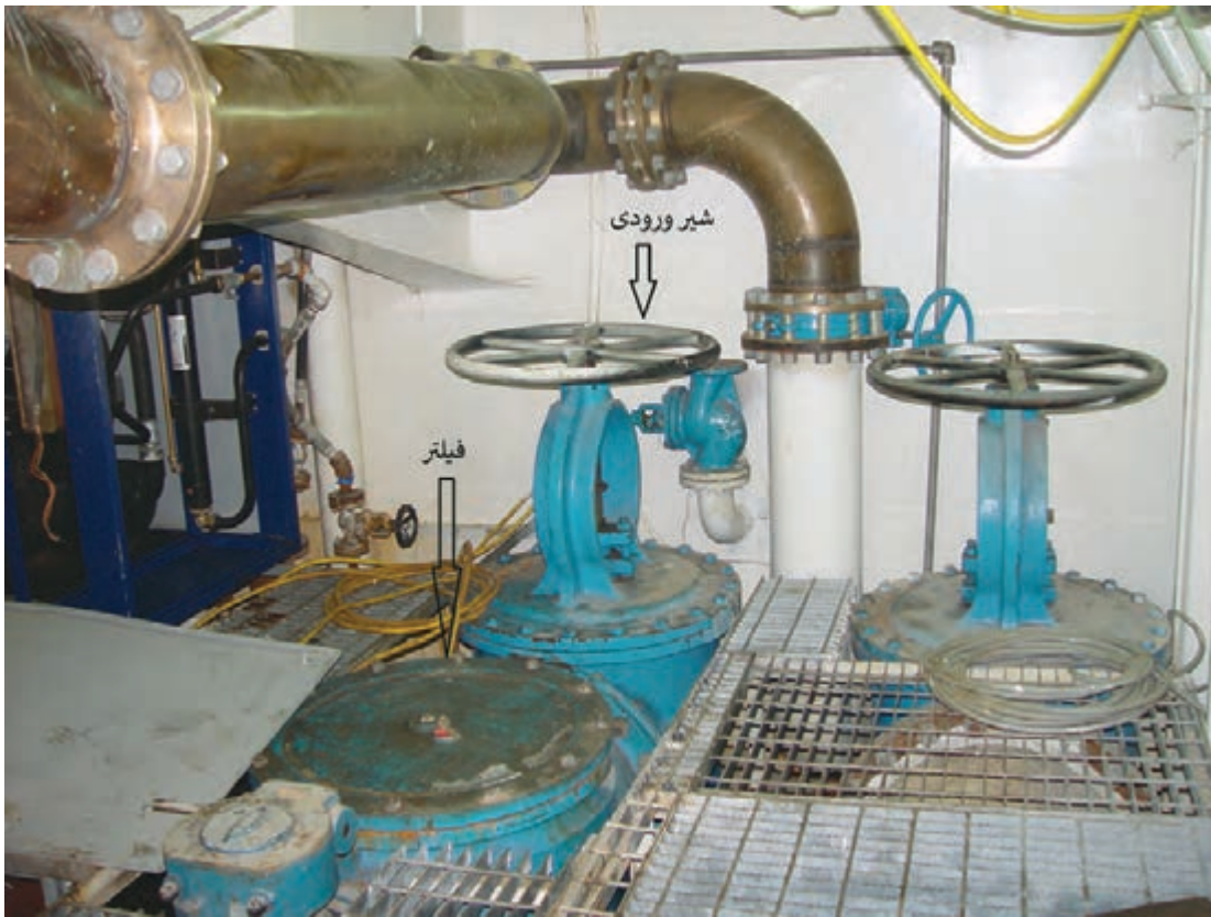
شکل ۳- نمونه‌ای از سامانه ورود و توزیع آب دریا
