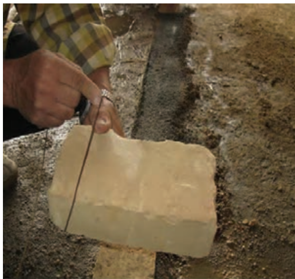
شکل ۱- ۸۹: نحوه بستن ریسمان کار به آجر
