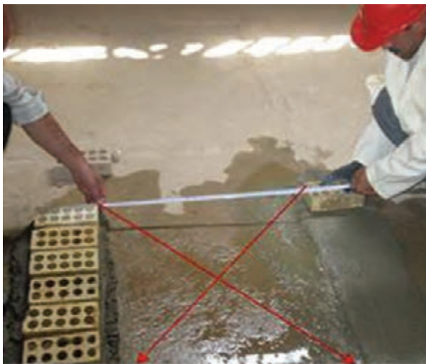
شکل ۱ - ۳۳ (ب): جدا کردن اندازه دو طرف دیگر
