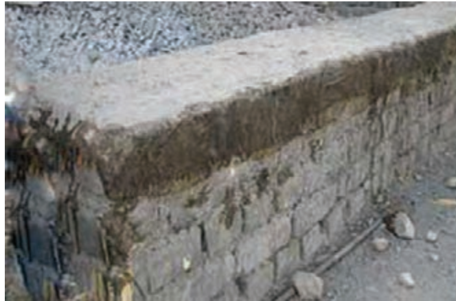
شکل ۱- ۲۹: کرسی چینی یا عایق کاری رطوبتی
