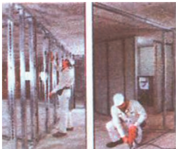
شکل ۱-۴۴: قاب‌سازی جهت اتصال روکش‌های گچی
