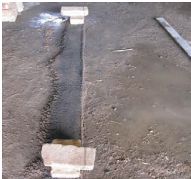
شکل ۱- ۹۰: بادخور نمودن ریسمان کار
