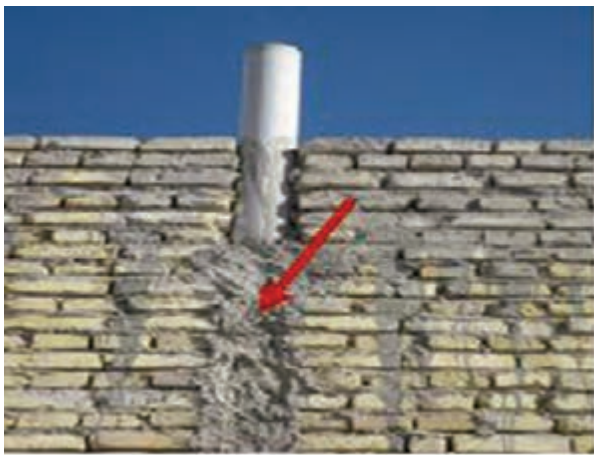
شکل ۱ - ۶۵: پر کردن درز لوله‌ها
