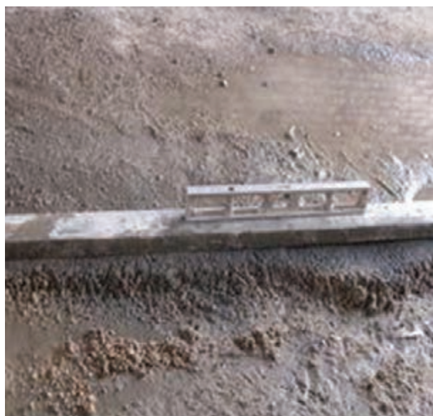
شکل ۱ - ۸۶: کنترل تراز سطح ملات
