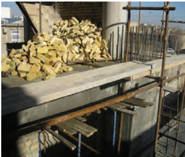
شکل ۱-۲: ضخامت مناسب برای تخته زیر پای
