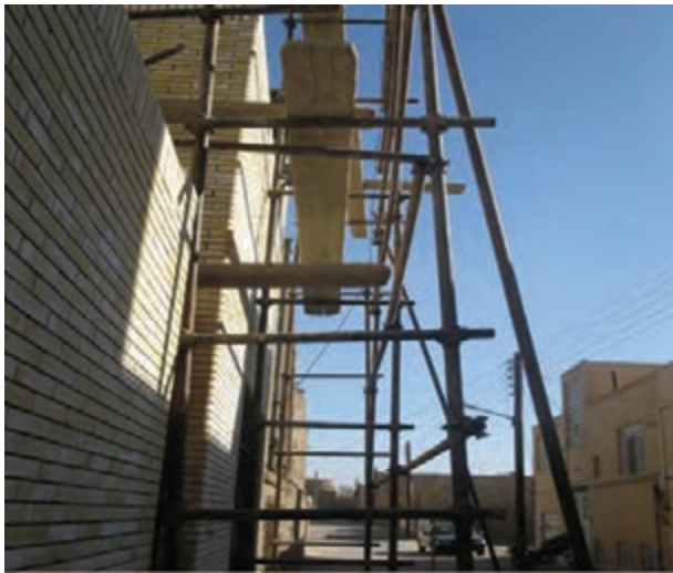
شکل ۱-۱: داربست فلزی برای چیدن دیوار
