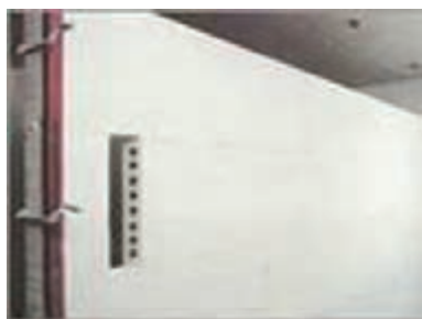
شکل ۱ - ۳۷: دیوار جداکننده با قطعات پیش ساخته گچی
