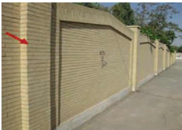
شکل ۱ - ۵۸ : وابند در دیوار حصارکشی
