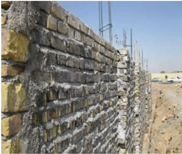
شکل ۱- ۲۶: دیوار آجری با کلاف بندی قائم
