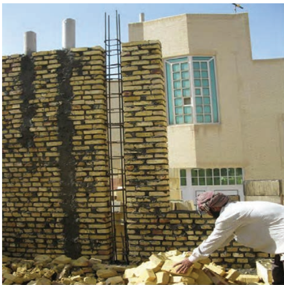
شکل ۱ - ۶۰: اتصال کلاف قائم و افقی در دیوار
