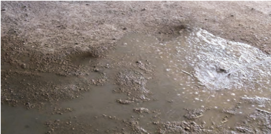
شکل ۱-۶۷: خیس کردن سطح زیر کار
