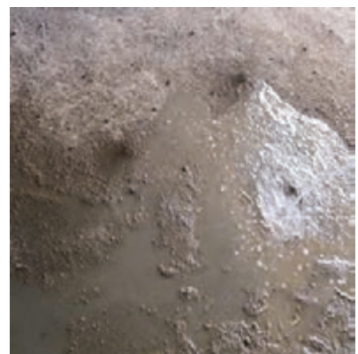
شکل ۱-۱۰۳: خیس کردن سطح زیر کار
