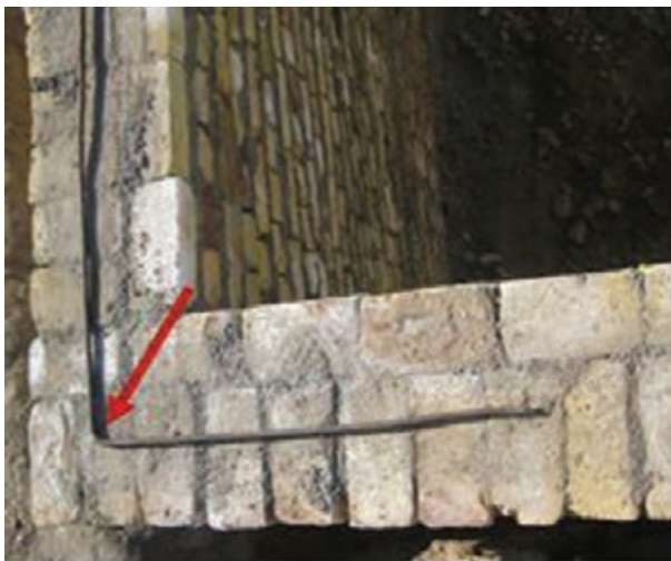
شکل ۱ - ۵۵: میلگرد گذاری در محل اتصال دو دیوار
