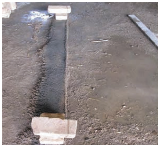
شکل ۱-۷۳: بادخور نمودن ریسمان کار
