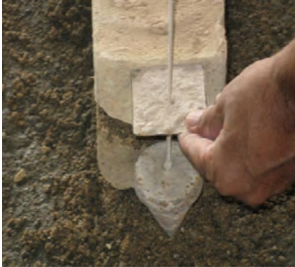
شکل ۱- ۷۷: شاقول کردن نبش کار
