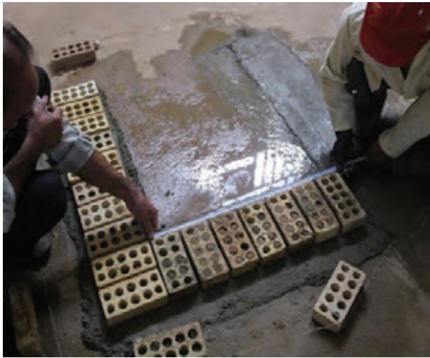
شکل ۱ - ۳۳ (الف): برداشتن طول دیوار
