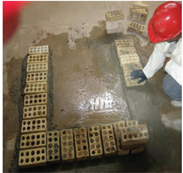
شکل ۱ - ۳۳ (ج): ریسمان کشی و چیدن ضلع سوم
