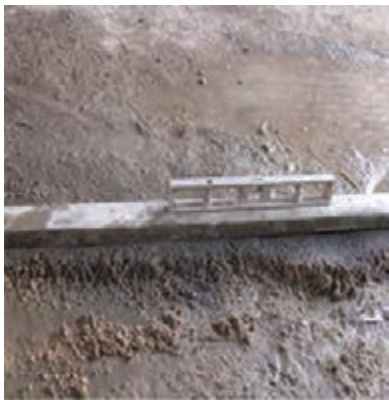
شکل ۱-۱۰۵: تراز کردن روی ملات
