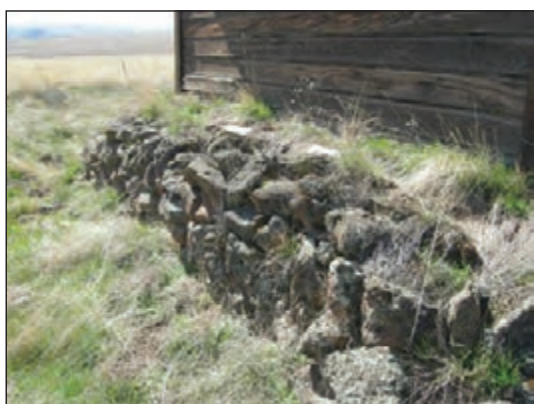
شکل ۳-۴۰ پی سنگی با سنگ لاشه
