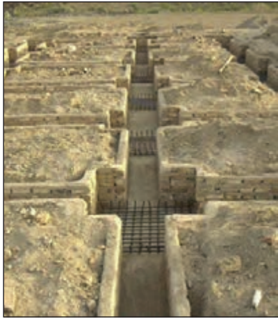
شکل ۳-۵۴ آرماتورگذاری پی تکی کلاف بندی شده
