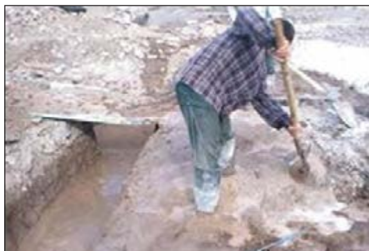
شکل ۳-۳۷ اجرای شفته آهک در فونداسیون
