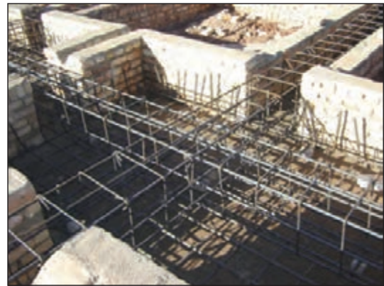
شکل ۳-۱۳۵ عبور میلگردهای شناژ در پی
