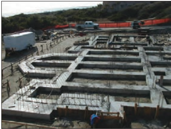
شکل ۳-۶۲ پی بتن مسلح نواری شبکه ای زیرستون
