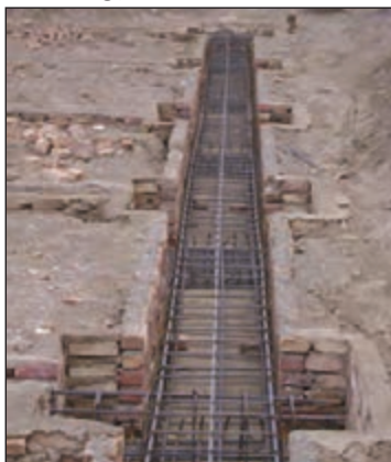
شکل ۳-۱۳۶ پی و شناژ قبل از بتن‌ریزی
