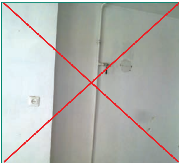
شکل ۷-۴ ب. فاصله شیر روشنایی از سقف کمتر از ۸۰ سانتی متر نباشد.
