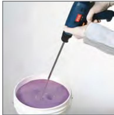
۱ مخلوط کردن لعاب با استفاده از همزن
