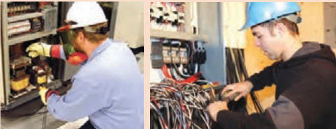
شکل ۱-۳- مقایسه نحوه کار ایمن با تجهیزات الکتریکی (چپ) و غیر ایمن (راست)
