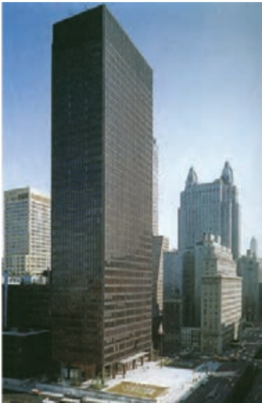
تصویر ۱- معماری مدرن ساختمان سیگرم، نیویورک، سال ۱۹۵۸-۱۹۵۴
