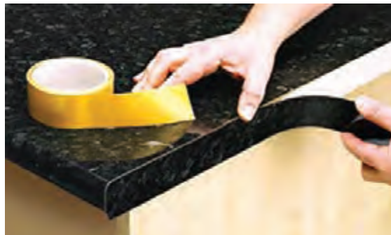
شکل ۱۱۹ - نصب نوار لبه صفحه تاپس
