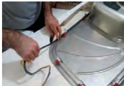
شکل ۱۰۴ - نصب نوار آب بندی پشت لبه سینک
