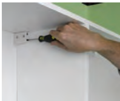
شکل ۲۳ - نصب کابینت با هنگر
