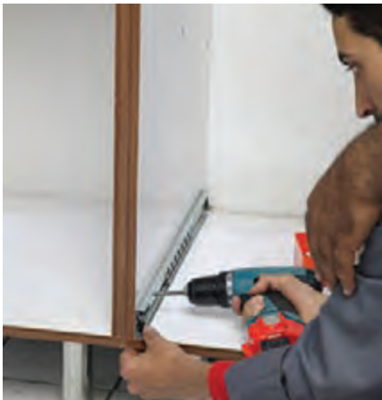
شکل ۸۲ - نصب قطعه یک تکه روی بدنه‌ها
