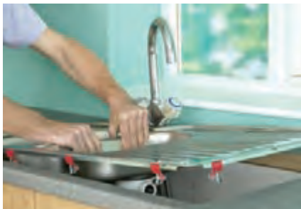
شکل ۱۰۵ - نصب سینک به کمک گیره های بست (کلیپس اتصال)
