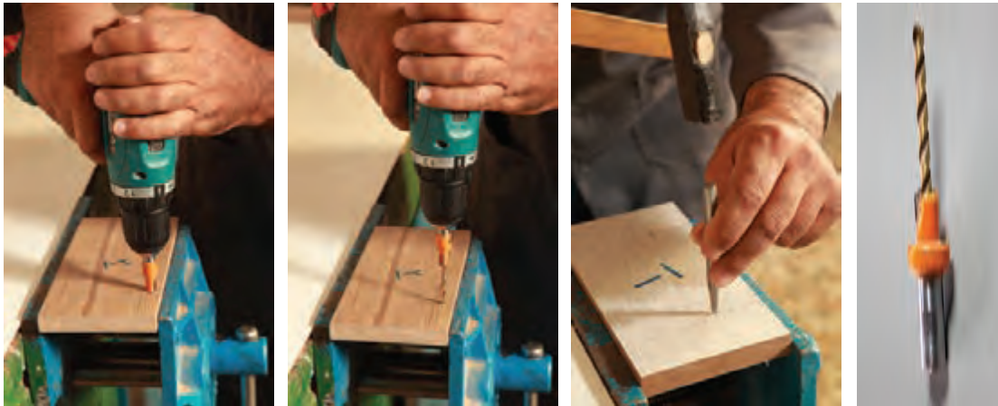
شکل ۵۲- شکل سوراخ کاری
