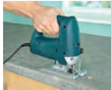
شکل ۱۰۱ - برش کاری محل قرارگیری سینک
