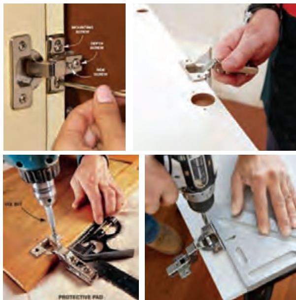
شکل ۴۹- نصب لولا روی در
