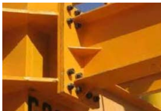
شکل ۱۸-۳ سازه فلزی اتصال پیچ و مهره (ب)
