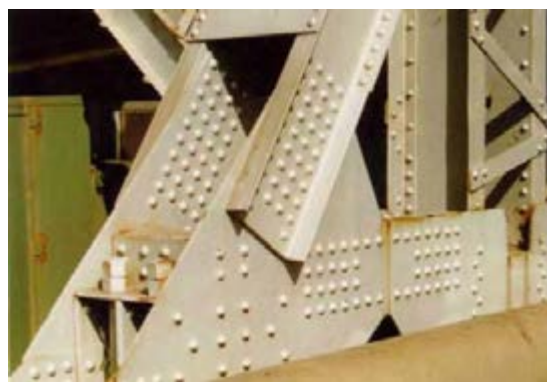
شکل ۱۸-۳ سازه فلزی اتصال پرچی (الف)
