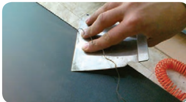
شکل ۲۵-۴ - نحوه برطرف کردن اضافه نوار با لیسسه
