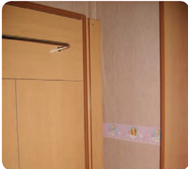
شکل ۱۲۴-۵- نصب مانع پشت در قبل از نصب سقف کمد لباس
