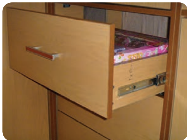
شکل ۱۵۷-۵- کشوی مجهز به ریل تلسکوپی سه ریله ضامن دار
