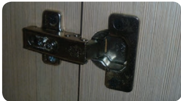
شکل ۵-۱۶۳- نصب لولای گازی فنردار به در کمد
