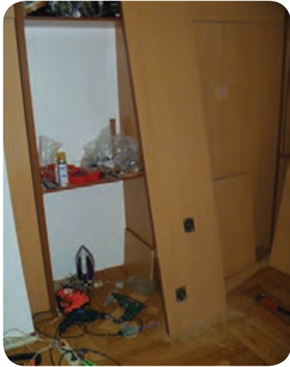
شکل ۱۲۶-۵- نصب یراق مقر پایه‌های جک تختخواب روی بدنه
