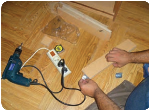
شکل ۱۷۹-۵- آماده کردن پاسنگ‌ها
