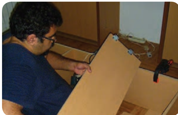
شکل ۵-۱۶۱- نصب طبقات به وسیله گونیاها فلزی
