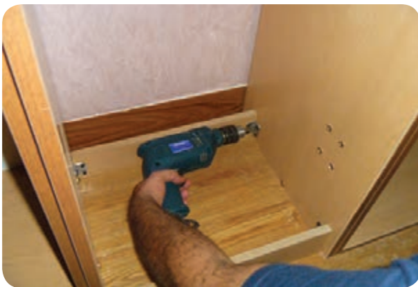
شکل ۱۸۰-۵- نصب پاسنگ‌ها
