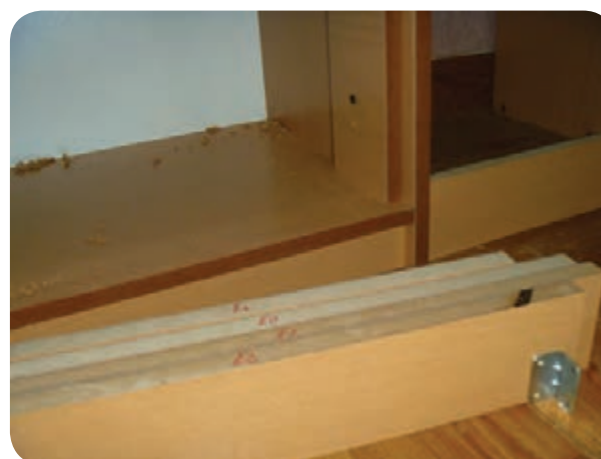
شکل ۱۶۶-۵- نصب پاننگ با استفاده از گونیای فلزی
