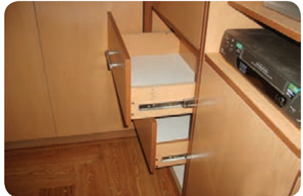
شکل ۱۷۷-۵- نصب کشویی تلسکوپی سه ریله برای کشو
