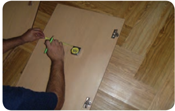
شکل ۱۵۰-۵- نصب لولای در کمد
