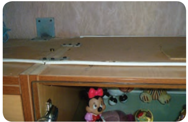
شکل ۵-۱۸۱- اتصال قسمت های مختلف دکور به یکدیگر و به دیوار
