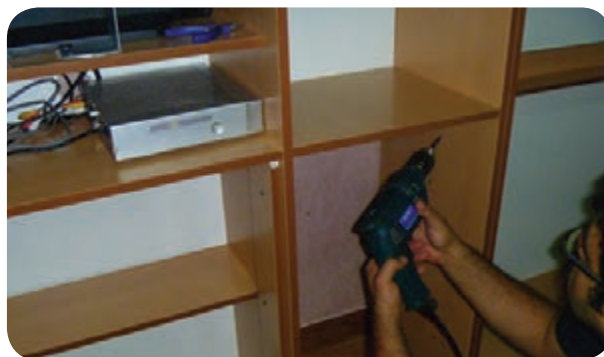
شکل ۱۷۲-۵- نصب صفحه میز آرایش
