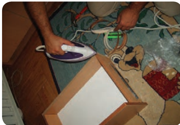
شکل ۱۵۴-۵- نوار چسبانی به نر (ضخامت) کشوها با اتوی داغ
