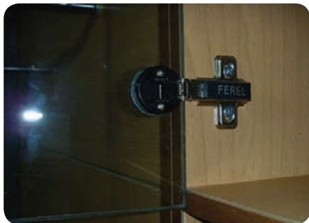
شکل ۱۴۳-۵- نصب لولای شیشه‌ای گازی برای در شیشه‌ای ویتزین
