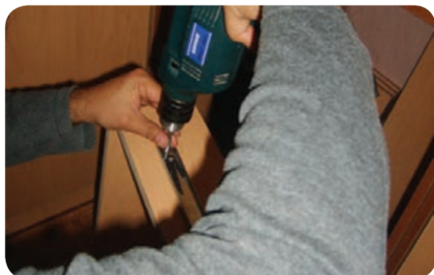
شکل ۱۷۶-۵- نصب ریل تکی به بدنه کشو
