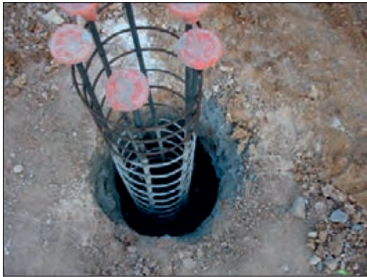
شکل ۱-۷۳ پی چاهی در حال اجرا
