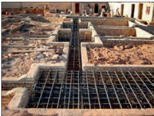
شکل ۷۰-۲ میلگردگذاری در پی کلاف بندی
