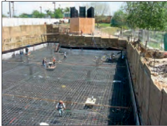
شکل ۱-۶۲ پی بتن مسلح یکپارچه (رادیه ژنرال)
