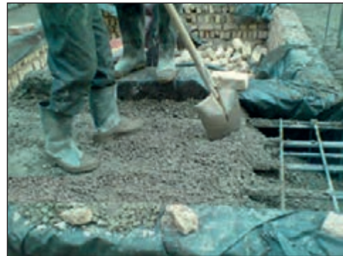
شکل ۲-۱۴۵ مرحله ی بتن ریزی داخل پی
