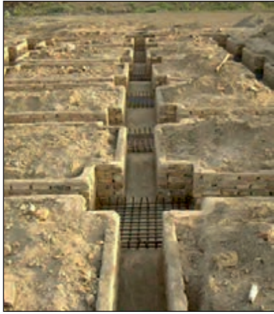
شکل ۴۸-۱ آرماتورگذاری پی تکی کلاف بندی شده
