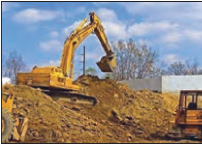
شکل ۱-۱۳- کندن زمین با وسایل مکانیکی
