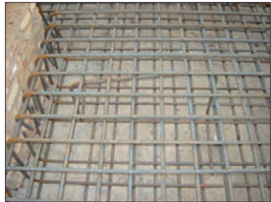
شکل ۱۴۷-۲ پی نواری و آرماتورگذاری آن
