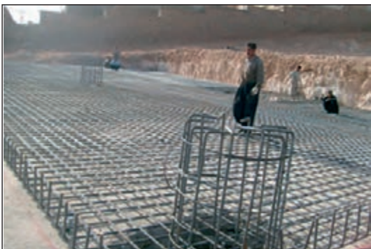
شکل ۱۵۲-۲ آرماتورگذاری پی صفحه‌ای با ستون‌های بتنی
