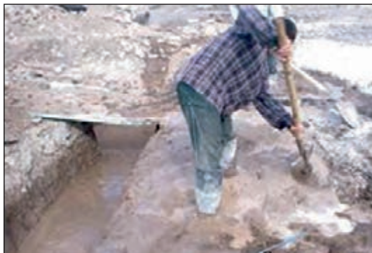
شکل ۱-۳۱ اجرای شفته آهک در فونداسیون
