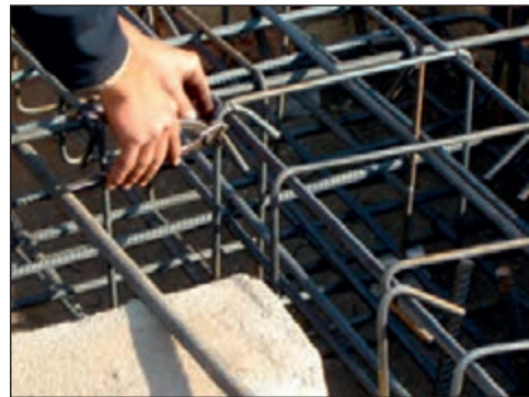
شکل ۲-۱۴۱ بستن خاموت دورآرماتور اصلی شناژ
