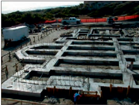
شکل ۱-۵۶ پی بتن مسلح نواری شبکه ای زیرستون
