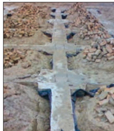
شکل ۷۳-۲ پی و شناژ بعد از بتن ریزی
