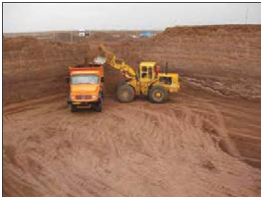
شکل ۸۵-۱ گودبرداری با لودر در زمین نامحدود
