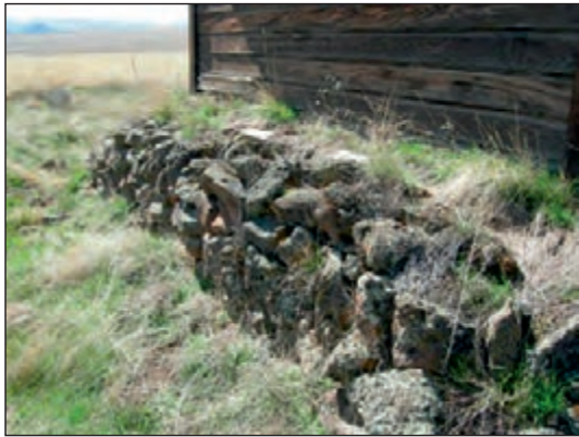
شکل ۱-۳۲ پی سنگی با سنگ لاشه
