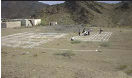
شکل ۸۳-۱ پیاده کردن نقشه روی زمین
