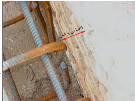
شکل ۱۲۶-۲ فاصله‌ی پوشش و قلاب سر میل‌گردها
