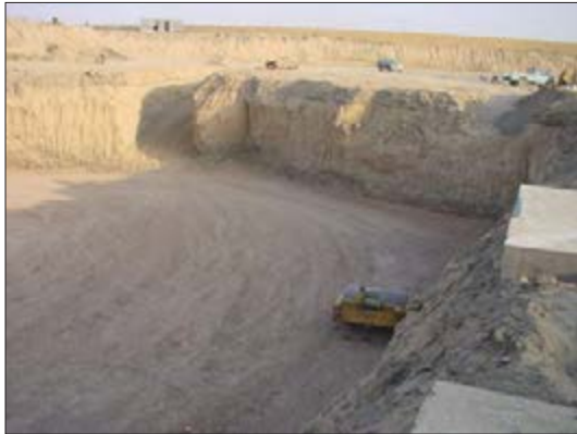
شکل ۸۴-۱ زمین گودبرداری شده
