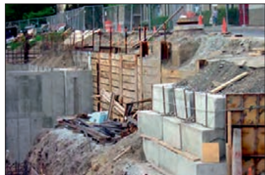
شکل ۹۱-۱ مهاربندی با دیوار مانع چوبی
