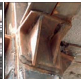
اتصال تیر به ستون به صورت لچکی
