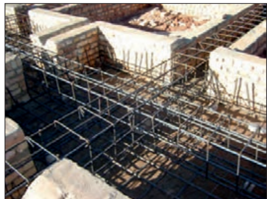
شکل ۷۱-۲ عبور میلگردهای شناژ در پی
