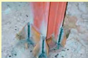
اتصال مناسب و جوش صحیح
