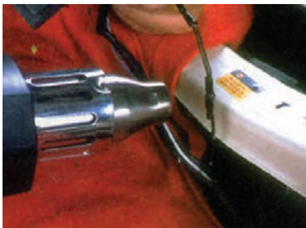
شکل ۱-۱۵۰- عایق کاری محل اتصال سیم ها
