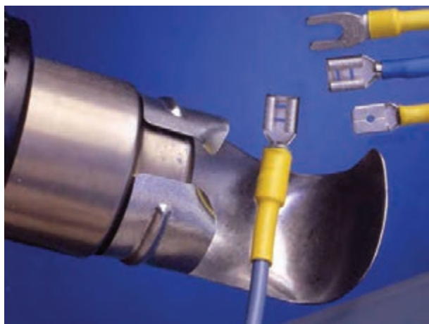
شکل ۳۱-۶ عایق کاری محل اتصال سیم و سرسیم
