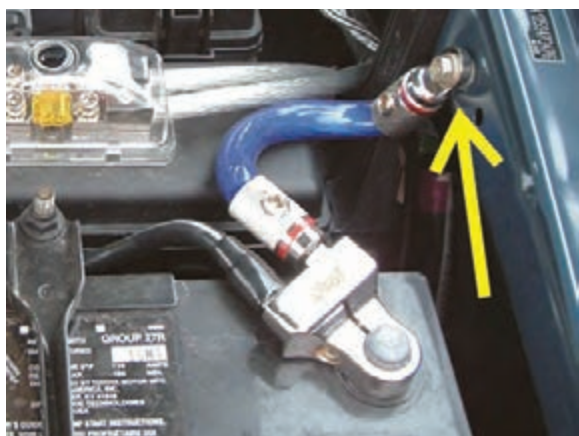
شکل ۲-۲۴ اتصال کابل منفی باتری به بدنه
