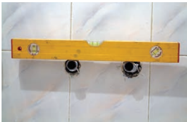
شکل ۲-۱۶۹- کنترل صاف بودن دنباله‌ها
