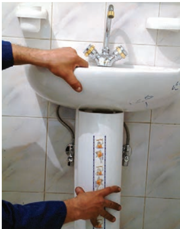
شکل ۳-۵۸- قرار دادن پایه‌ی دست‌شویی در زیر آن
