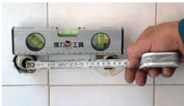
شکل ۲-۱۸۶- کنترل صاف بودن و اندازه‌ی دنباله‌ها
