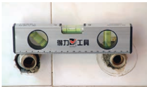
شکل ۲-۲۰۳- کنترل تراز بودن دنباله‌ها
