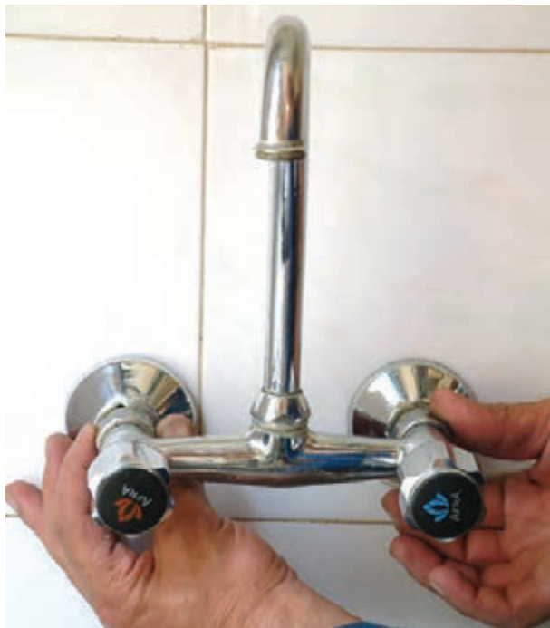
شکل ۱۷۲-۲- پیچیدن مهره‌ها به دنباله‌های شیر مخلوط
