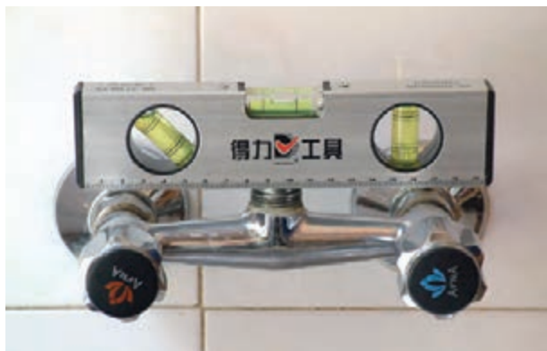
شکل ۱۷۴-۲- سنجش تراز بودن شیرمخلوط دیواری
