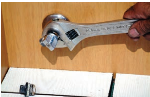
شکل ۳-۲۵۴- سفت کردن شیر پیسوار
