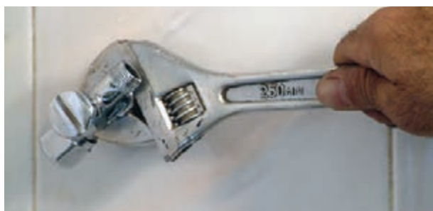
شکل ۳-۴۸ سفت کردن شیر پیسوار با آچار فرانسه
