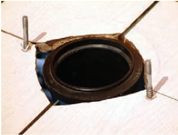
شکل ۲۴۷-۳- بستن پیچ‌های روکا در داخل رولپلاک‌ها
