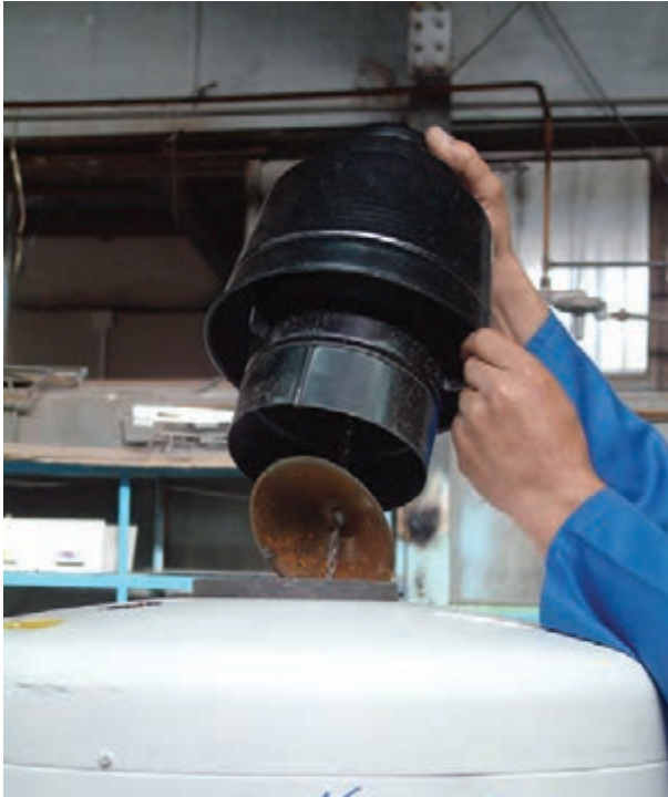
شکل ۱-۱۱۵- برداشتن کلاهک تعدیل از روی دودکش
