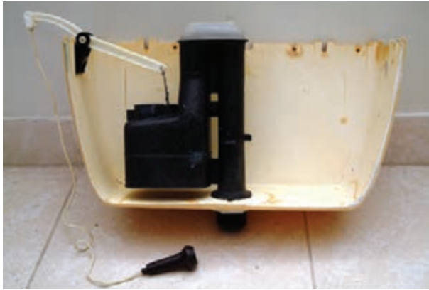
شکل ۳-۲۰۷- نصب پمپ تخلیه درون مخزن فشار
