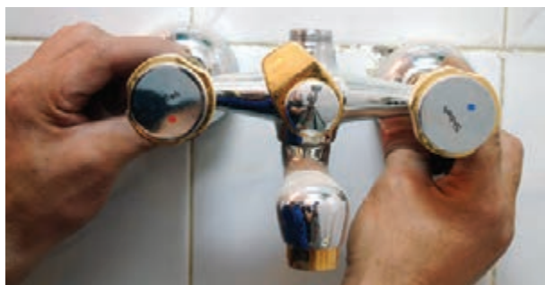
شکل ۲-۲۰۵- بستن مهره‌های شیر مخلوط دوش با دست
