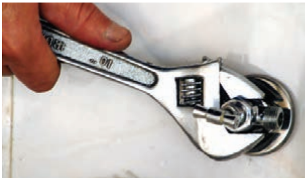
شکل ۱۴۴-۲- سفت کردن شیر پیسوار با آچار فرانسه
