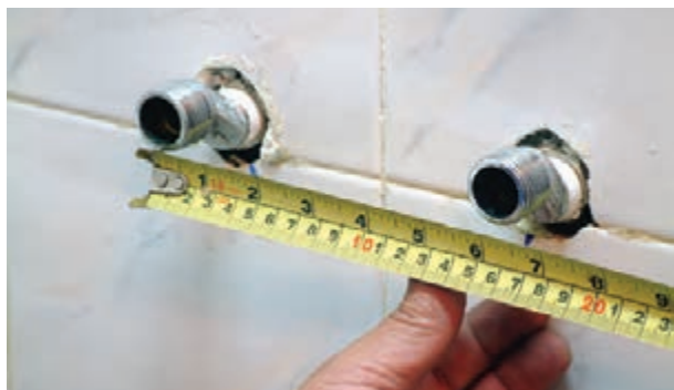
شکل ۱۶۸-۲ کنترل اندازه‌ی محور تا محور دنباله‌ها
