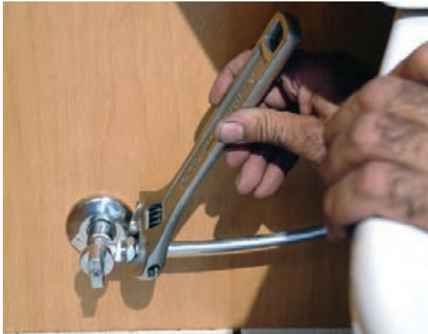
شکل ۳-۲۵۶- سفت کردن مهره‌ی شیر پیسوار
