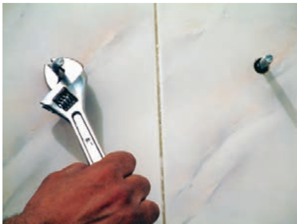
شکل ۳-۴۴- سفت کردن پیچ‌ها در درون رولپلاک‌ها
