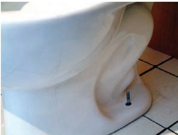
شکل ۲۴۸-۳- قرار دادن توالت فرنگی در محل خود
