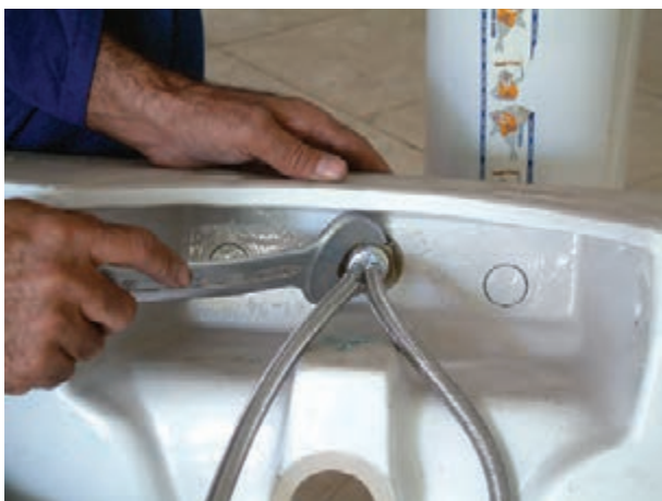
شکل ۳-۳۹- نصب شیر مخلوط توکاسه بر روی دست شویی
