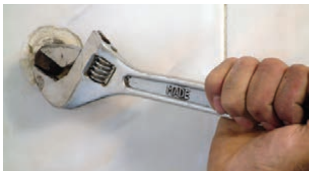
شکل ۱۹۸-۲- باز کردن درپوش‌ها
