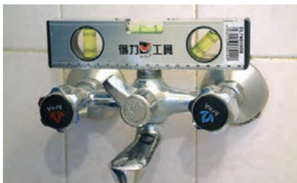
شکل ۲-۲۰۷- سنجش تراز بودن شیر مخلوط دوش
