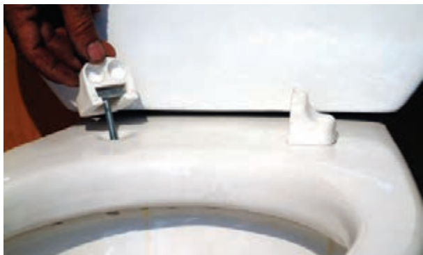
شکل ۳-۲۵۳- اتصال بست‌های نگهدارنده به توالت فرنگی
