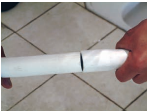
شکل ۲۰۶-۳- جا زدن لوله‌های تخلیه در درون یکدیگر
