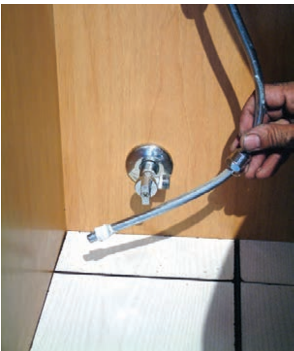
شکل ۳-۲۵۵- خمکاری لوله‌ی پیسوار
