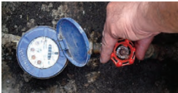
شکل ۱۹۵-۲- باز کردن شیرفلکه‌ی اصلی
