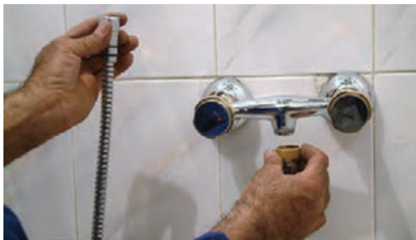
شکل ۱۹۱-۲- اتصال شیلنگ آفتابه به شیر مخلوط توالت
