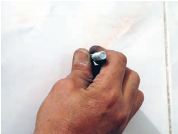
شکل ۳-۴۳- بستن پیچ‌ها در درون رولپلاک‌ها با دست
