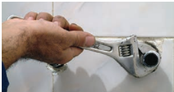
شکل ۱۶۷-۲ سفت کردن دنباله‌ها با آچار فرانسه
