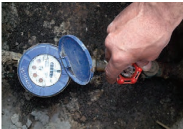
شکل ۲-۶۰ بستن شیر فلکه‌ی اصلی آب ساختمان
