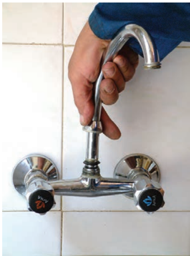
شکل ۲-۱۷۵- جازدن عَلم شیر مخلوط با دست در درون نافی شیر مخلوط
