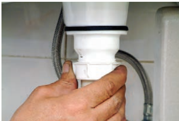
شکل ۳-۵۶- بستن مهره‌ی لوله‌ی عمودی سیفون به زیراب
