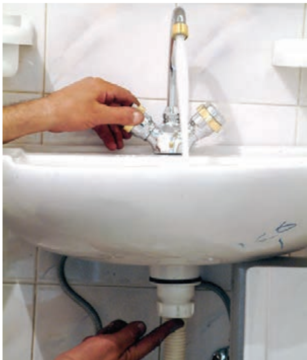
شکل ۳-۵۷- عمل کنترل نشت آب از محل‌های اتصال
