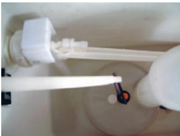
شکل ۲۲۴-۳- بر شدن مخزن فشاری
