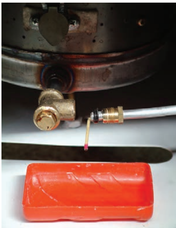
شکل ۱-۵۳- قطع جریان نفت به کوره
