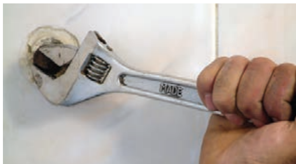
شکل ۲-۱۸۲- بازکردن درپوش‌ها
