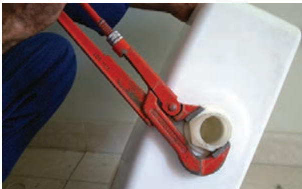
شکل ۳-۲۰۸- سفت کردن مهره‌ی پمپ تخلیه
