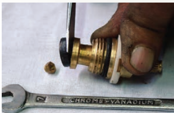
شکل ۲-۶۳- تعویض واشر
