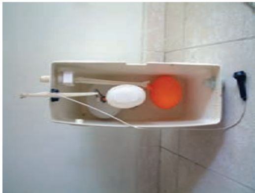
شکل ۳-۲۳۳- مخزن فشاری برش نخورده
