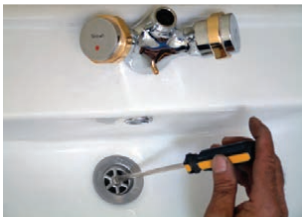
شکل ۳-۴۰ نصب زیراب بر روی دست شویی
