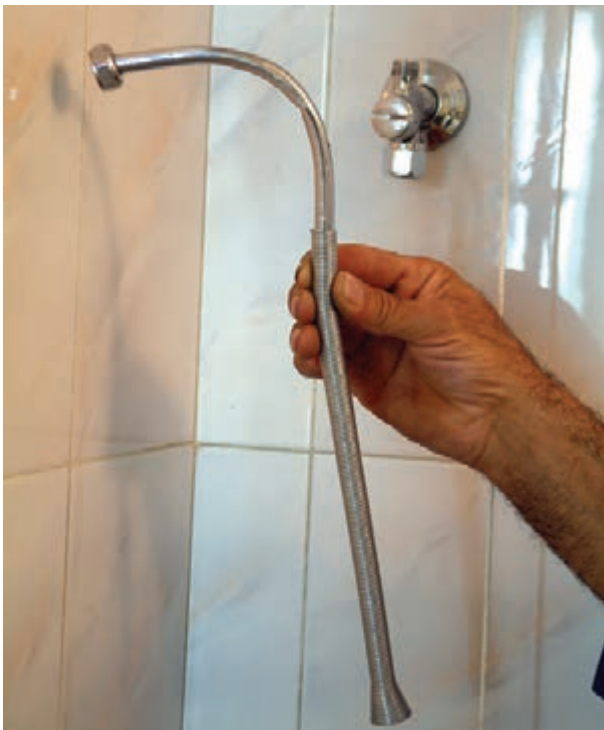
شکل ۳-۲۲۱ خم زدن لوله‌ی پیسوار به وسیله‌ی فنر لوله خم کن
