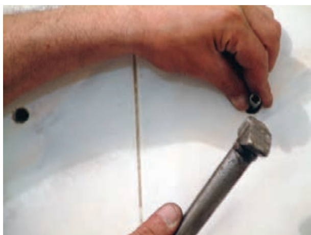
شکل ۳-۴۲ کوبیدن رولپلاک ها در درون سوراخ ها
