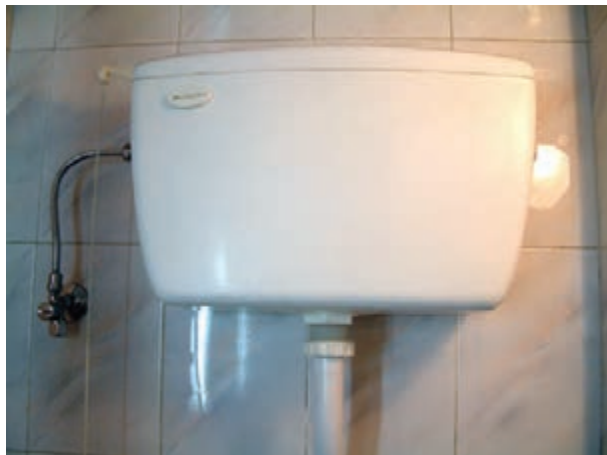
نصب مخزن فشاری
