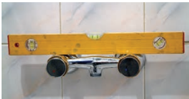
شکل ۱۹۰-۲- سنجش تراز بودن شیر مخلوط
