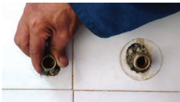
شکل ۲-۱۸۴- بیچیدن دنباله‌ها به محل نصب شیر
