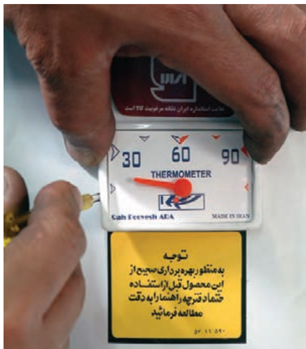
شکل ۱-۱۱۷- جدا کردن ترمومتر از روپوش
