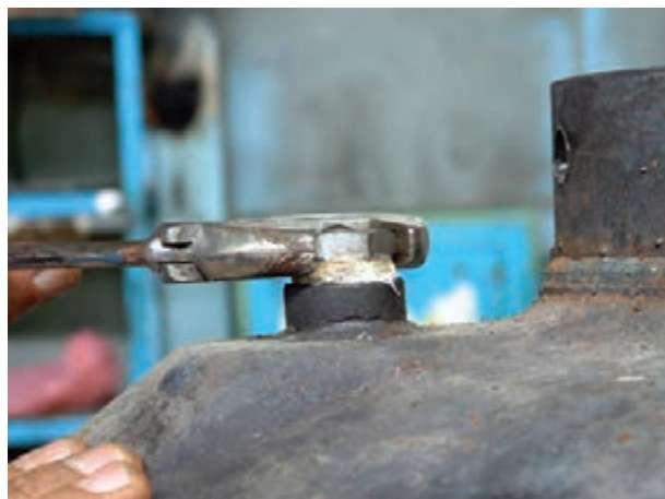
شکل ۱-۲۴- نحوه‌ی بازکردن میله‌ی منیزیم از محل خود
