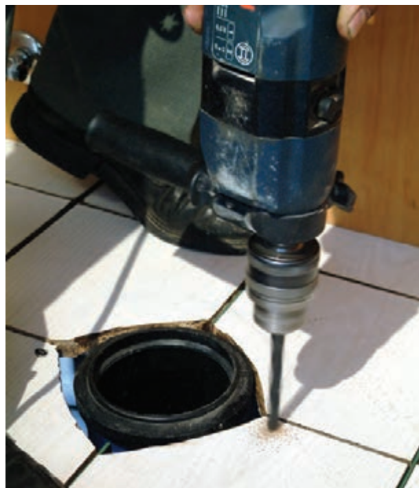
شکل ۲۴۶-۳- سوراخ‌کاری محل‌های علامت‌گذاری شده
