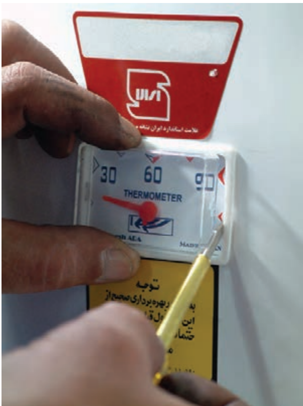
شکل ۱-۱۱۶- جدا کردن ترمومتر
