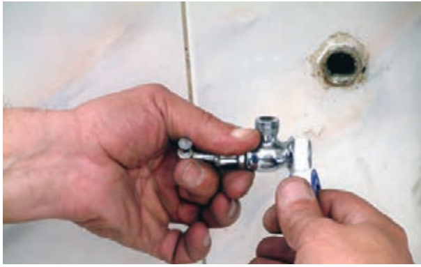
شکل ۳-۲۱۹ پیچیدن نوار تفلون به دنده‌ی \frac{1}{4} " شیر پیسوار
