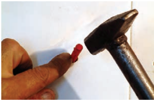
شکل ۱۹۳-۲- کوبیدن رولپلاک درون سوراخ
