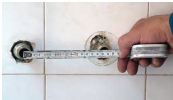
شکل ۲-۲۰۲- کنترل نمودن فاصله‌ی دنباله‌ها به وسیله‌ی متر
