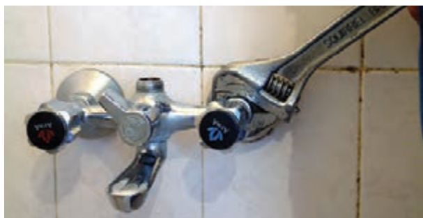
شکل ۲-۲۰۶- سفت کردن مهره‌های شیر با آچار
