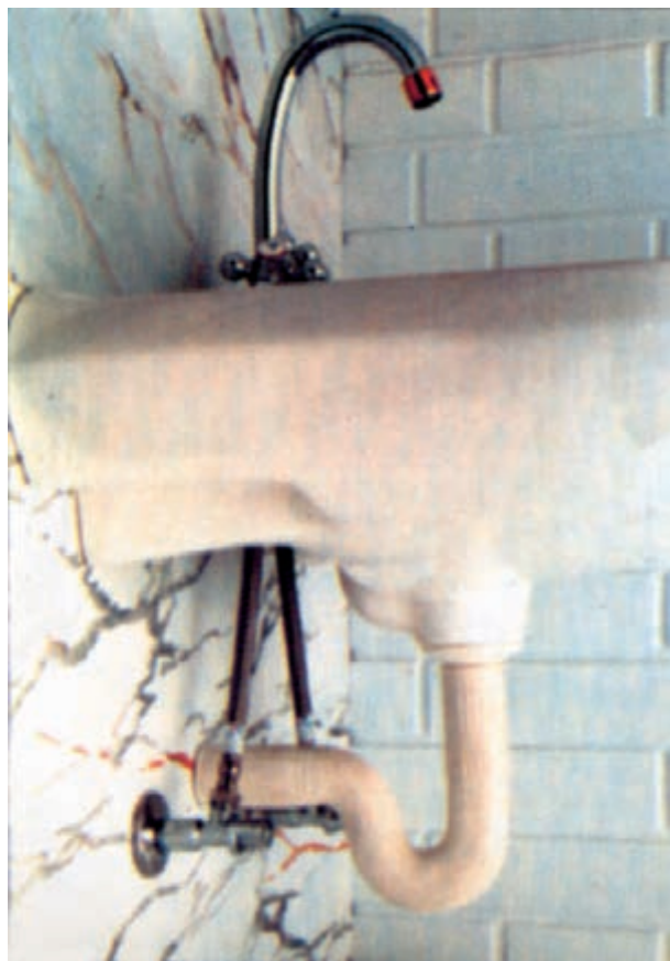
شکل ۱۸-۲ - اتصال شیرهای پیسوار به وسیله‌ی شیلنگ‌های فشار قوی دو سر مهره به شیر مخلوط توکاسه
