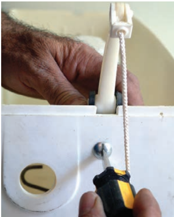
شکل ۳-۲۰۹- اتصال اهرم به بدنه‌ی مخزن فشاری
