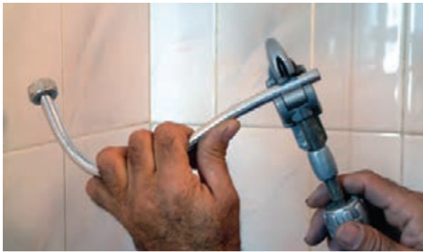
شکل ۲۲۲-۳- بریدن لوله‌ی پیسوار به وسیله‌ی لوله‌بر
