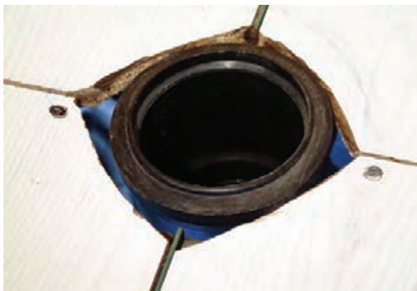
شکل ۲۴۴-۳- قرار دادن بوگیر در داخل زانویی
