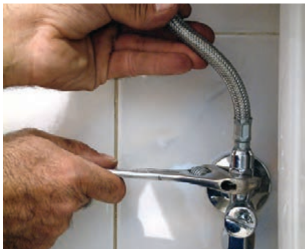
شکل ۳-۴۹ سفت کردن مهره‌های شیلنگ به شیر پیسوار
