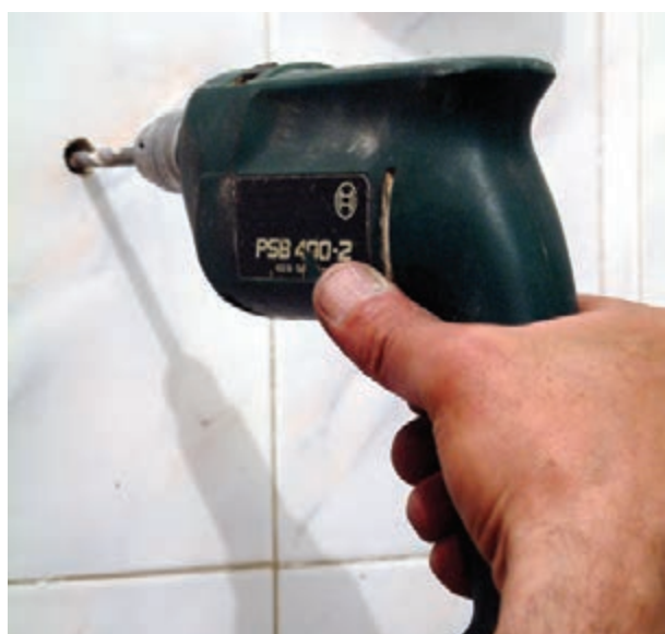
شکل ۳-۴۱ سوراخ کاری محل نصب پیچ ها
