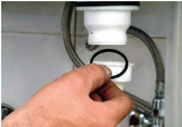
شکل ۳-۵۵- قرار دادن واشر آب‌بندی در درون مهره‌ی سیفون
