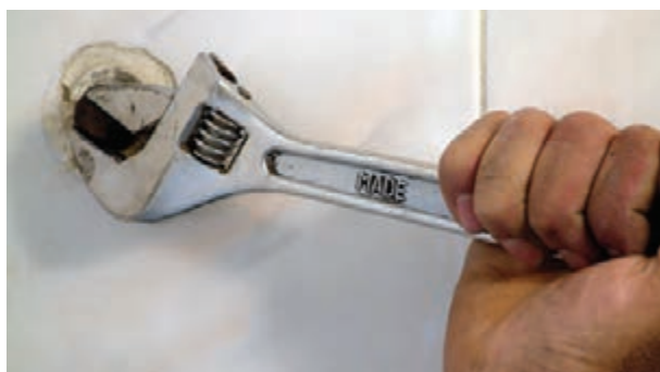
شکل ۱۴۱-۲ باز کردن درپوش
