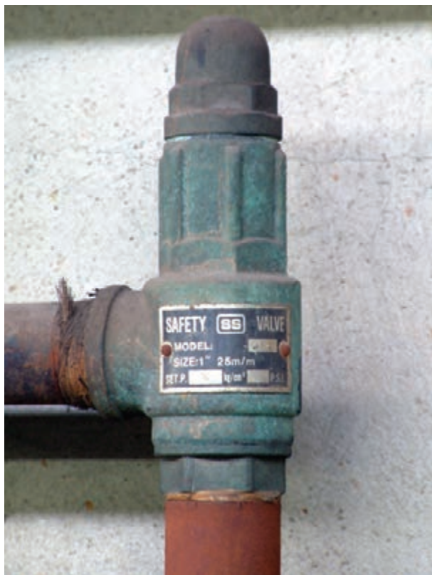
شکل ۲-۱۰۶- شیر اطمینان حساس در برابر فشار
