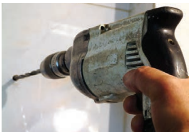
شکل ۱۹۲-۲- سوراخ کردن محل نصب بست آویز
