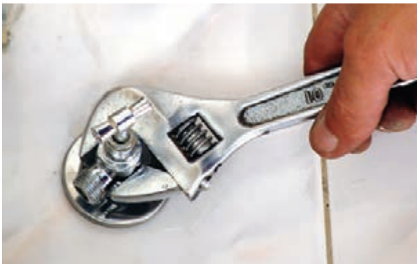
شکل ۳-۲۲۰ سفت کردن شیر پیسوار با آچار فرانسه
