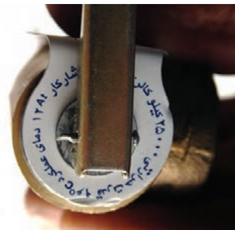
شکل ۲-۱۰۸- شیر اطمینان فشاری و حرارتی
