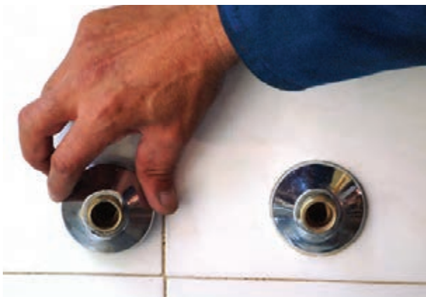
شکل ۲-۱۷۰- بستن کاسه‌ها به دنباله‌ها با دست
