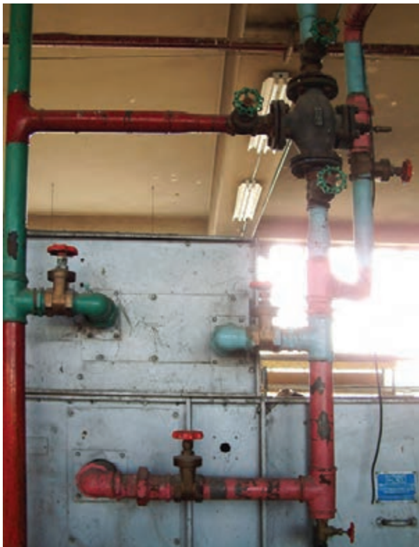
شکل ۲-۸۳ – مورد استفاده‌ی شیر فلکه در تهویه‌ی مطبوع
