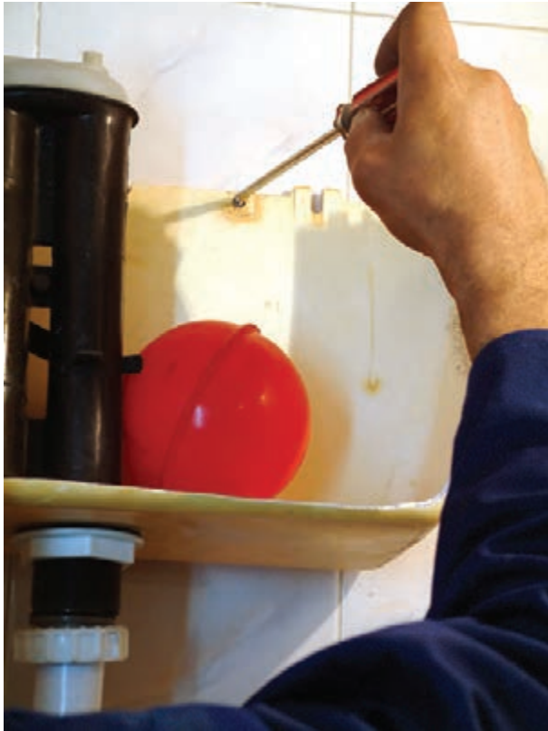
شکل ۲۱۳-۳- نصب مخزن فشاری به دیوار
