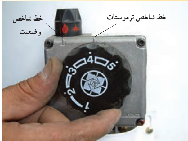
شکل ۱-۱۱۰- تغییر کلید تنظیم دما (ترموستات)
