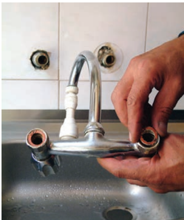
شکل ۲-۱۷۱- قراردادن واشر درون مهره‌ی تنه شیرمخلوط
