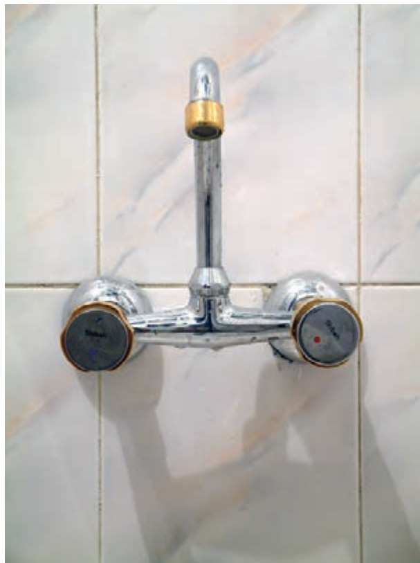
نصب شیر مخلوط دیواری
