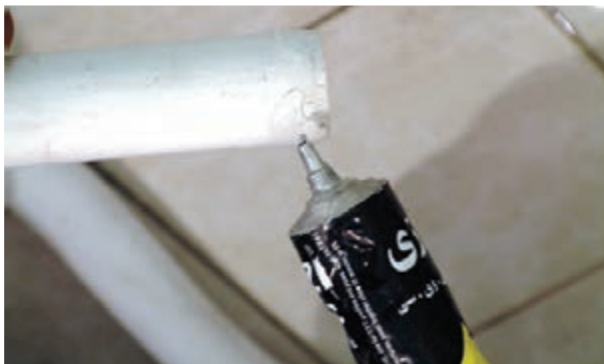
شکل ۲۰۵-۳- زدن چسب به لوله‌های تخلیه
