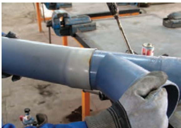
شکل ۲-۱۰- خارج کردن فیتینگ از سرکاسه
