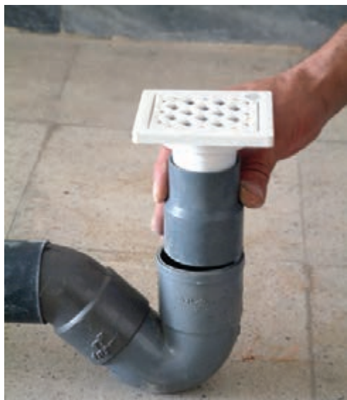
شکل ۳-۱۹- اتصال کف‌شوی به وسیله‌ی تبدیل
