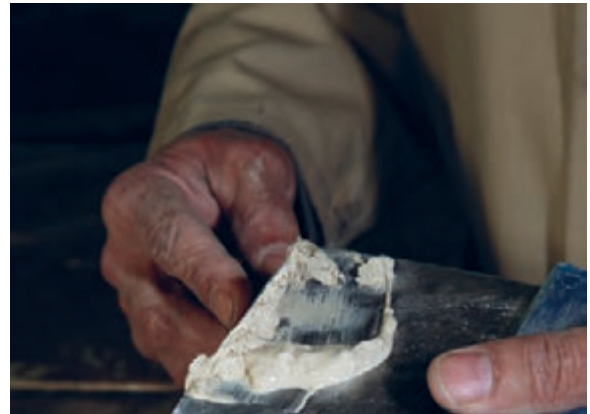
شکل ۴-۱۵- هر بار باید مقدار کمی بتونه روی لیسه قرار داد.
