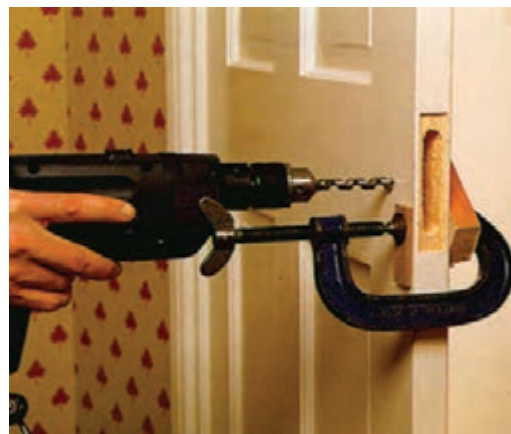
شکل ۱۰-۴۸- سوراخ‌کاری محل پلاک و دستگیره‌ی قفل.
