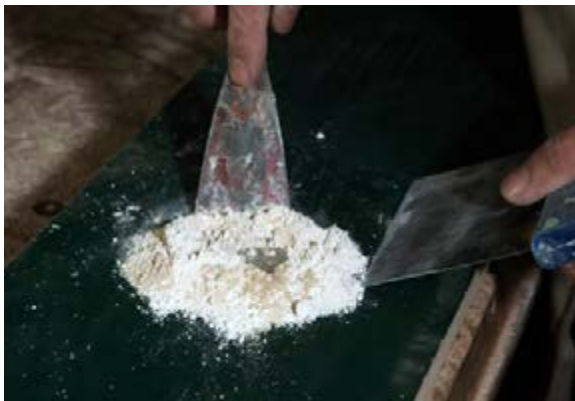
شکل ۴-۱۴- پگ‌ونگی کار کردن با کاردک و لیسه.
