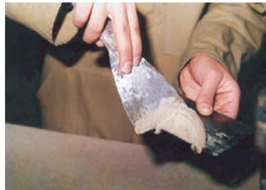
شکل ۸-۴- کاربرد لیسه و کاردک هنگام بتونه کاری.
