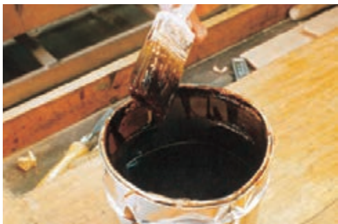
شکل ۴-۴۲- قلم‌موی آغشته به رنگ را باید به لبه‌ی قوطی کشید و رنگ اضافی را از آن گرفت.
