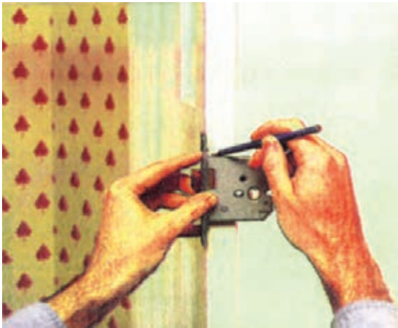
شکل ۱۰-۴۴-۱۰-۴۴. فلکشی ممل قفل (روی نر کار).
