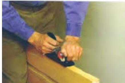
شکل ۲-۲۰- پوشالبرداری، یکنواخت و در جهت راه چوب باشد.
