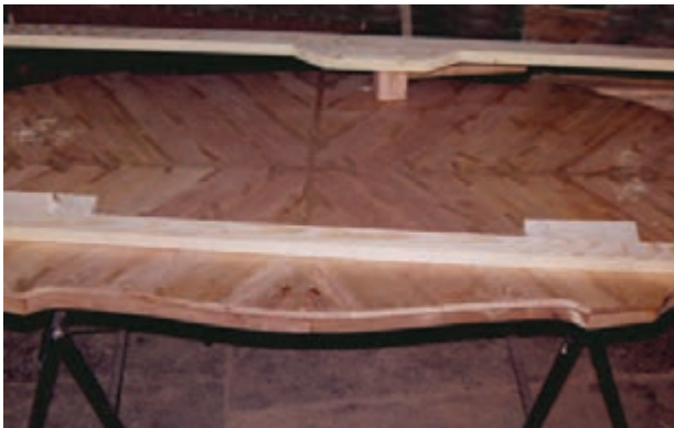
شکل ۱۱-۳۲- کلاف آماده شده برای شبکه‌ریزی.
