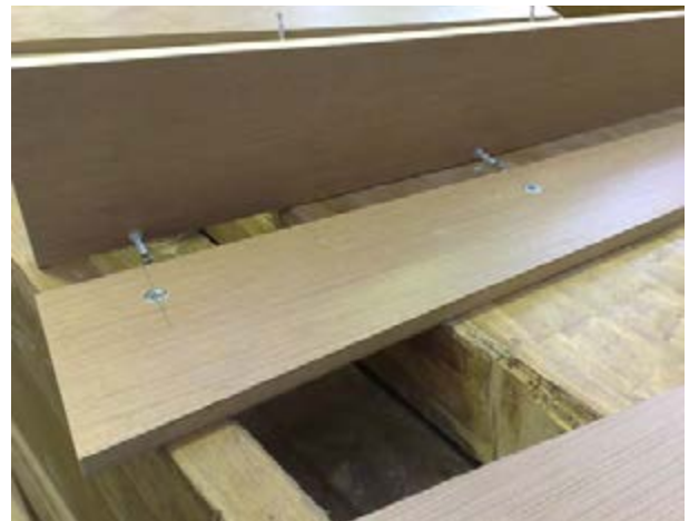
شکل ۱۲-۱۵- اتصال پایه‌ها به یکدیگر، با استفاده از اتصال ایت.
