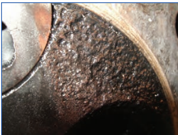
شکل ۲۷-۴- حفره‌های ایجاد شده بر اثر زنگ‌زدگی
