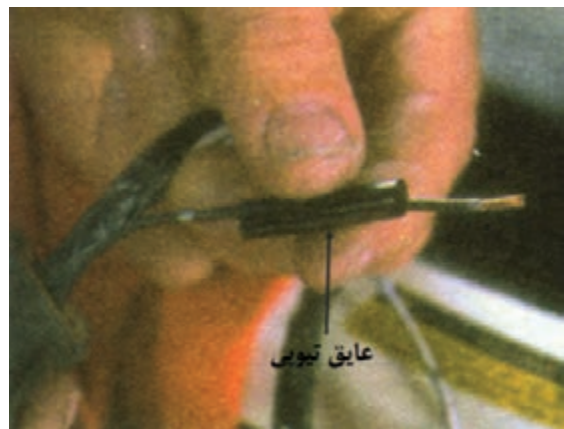
شکل ۶۳-۶- وارد کردن سیم به داخل عایق تیوبی
