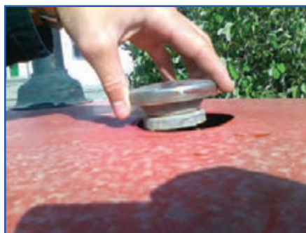
ب) باز کردن در رادیاتور
