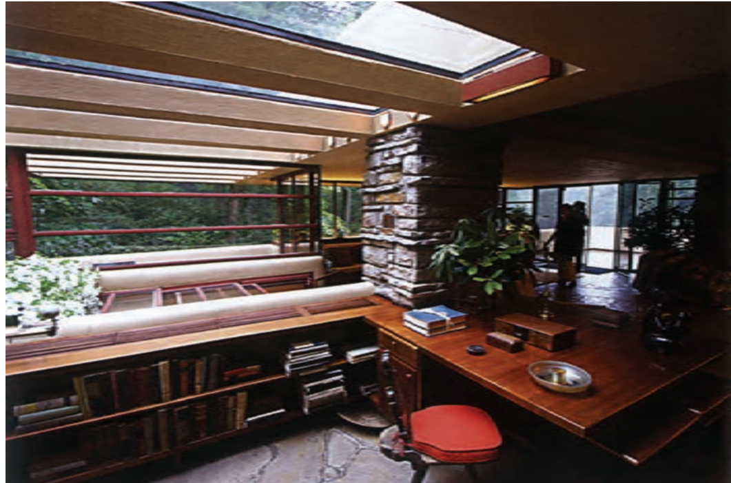
تصویر ۸-۴- نورگیر سقفی در فضای داخلی
