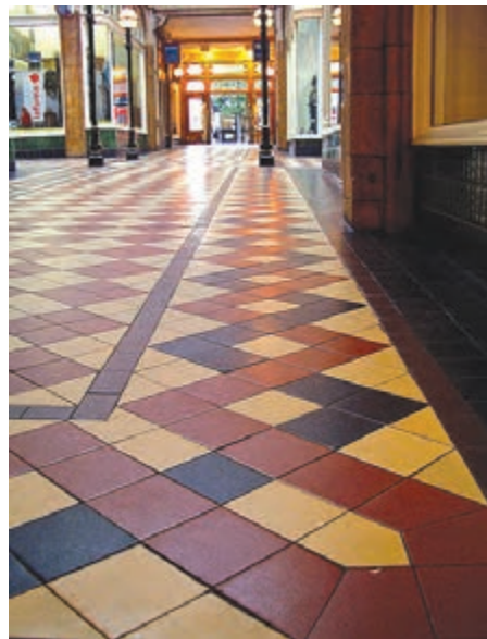
▲ شکل ۱-۷ کف‌سازی در داخل ساختمان
