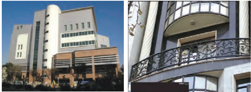
▶ شکل ۱-۱ کاربرد مصالح در نمای بیرونی ساختمان
