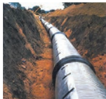
▲ شکل ۲-۲۲ لوله کشی انتقال آب شهری
