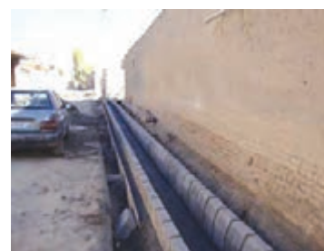
▲ شکل ۳-۳۳ جدول گذاری و ساخت جوی با جدول بتنی از پیش آماده
