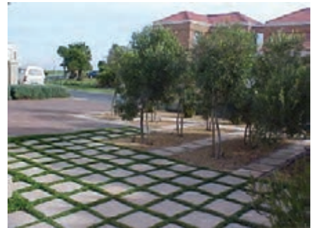
▲ شکل ۳-۵۴ رویه نهایی کف با بلوک‌های بتنی از پیش آماده
