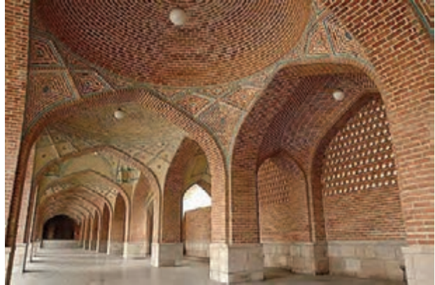
▲ شکل ۴-۶۸ قوس‌های آجری (مسجد کبود تبریز)
