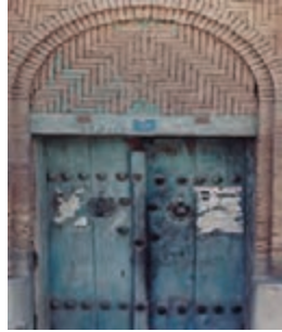
▲ شکل ۴-۷ کاربرد قوس در نعل درگاه
