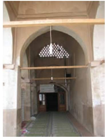
▲ شکل ۴-۷۲ کاربرد چوب در ساخت قوس‌ها
