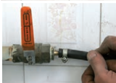
شکل ۱-۵ لوله‌های آب سرد، آب گرم و شیلنگ گاز در محل نصب آب گرم کن.
