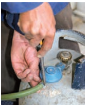
شکل ۱-۶۶ ب سفت کردن بست
