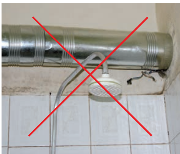
شکل ۳-۱۱ عبور غیر مجاز دودکش
