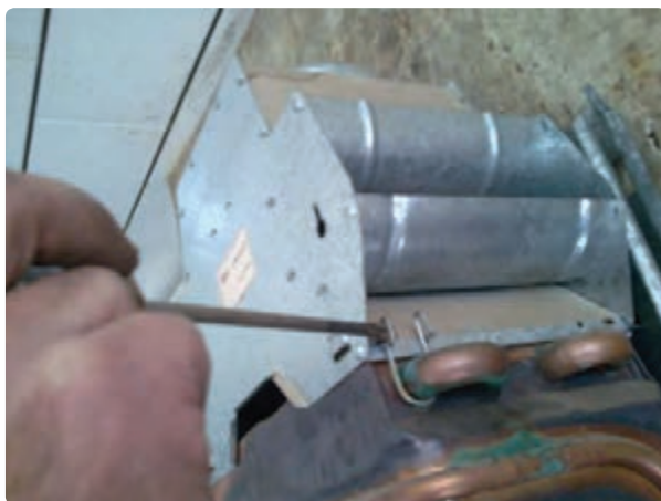
شکل ۶- جدا کردن کلاهک تعدیل از مبدل
