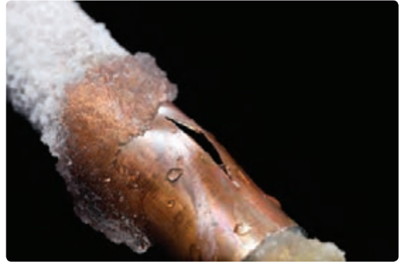
شکل ۶- شکستن لوله آب در اثر انجماد آب
