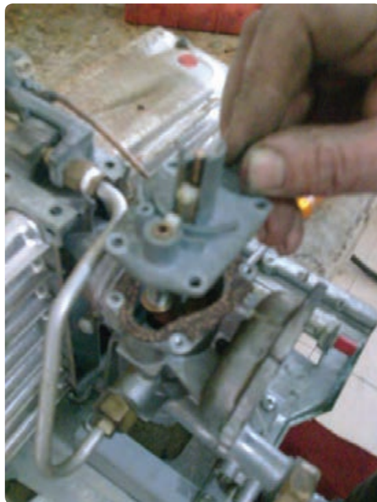
شکل ۲۰- رگولاتور گاز بر روی آب گرم‌کن
