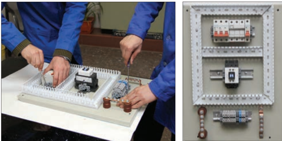
شکل ۸۴ - نصب تجهیزات دیگر
