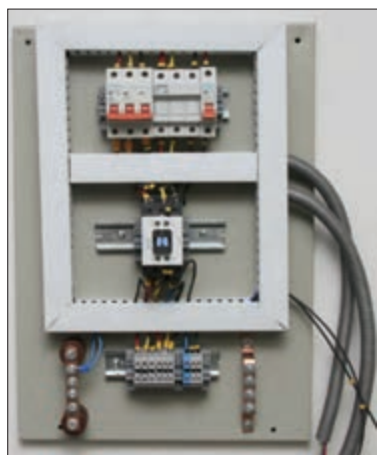
شکل ۹۱- تکمیل سیم‌کشی قطعات صفحه نصب
