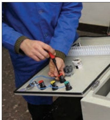
شکل ۹۳- سیم‌کشی چراغ‌های سیگنال
