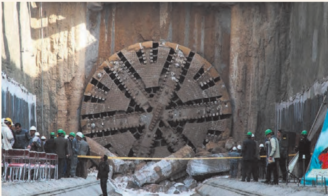
لحظه رسیدن دستگاه T.B.M خط ۲ مترو مشهد به ایستگاه ۴ (چهارراه گاز)
