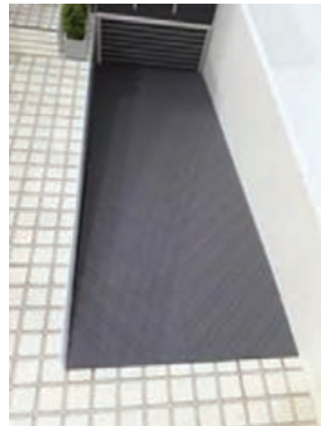
شکل ۱۰۹-۵- اجرای شیارهای رامپ با کاتر و فشار دست
