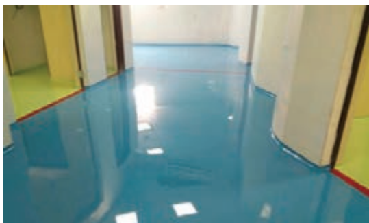
شکل ۴-۱۱ اپوکسی به عنوان لایه نهایی کفپوش
