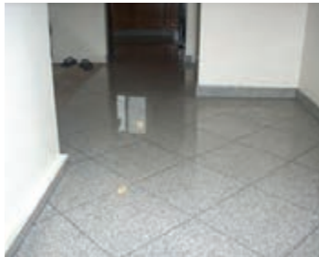
شکل ۳-۴۵- کف‌سازی نهایی با پوشش اپوکسی گرانیته شطرنجی
