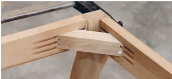
شکل ۱۲- اتصال انگشتی نبشی (بلوک سه‌گوش)
