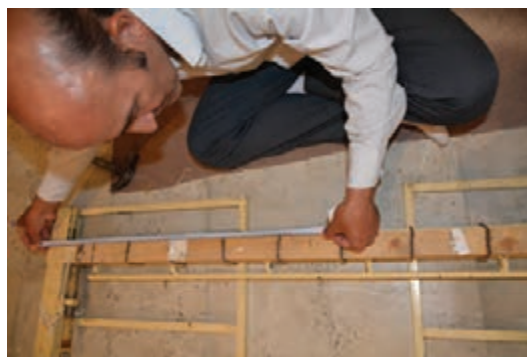
شکل ۱۸-۵ - نشانه گذاری بر روی چوب پایین کشی
