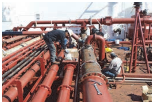
شکل ۷- در حال اجرای لوله‌کشی کشتی
