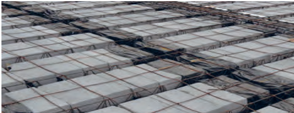
اجرای شناژ مخفی در سقف تیرچه بلوک
