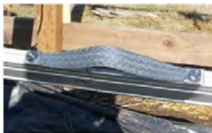
شکل ۲۹- همبندی در سامانه فتوولتاییک
