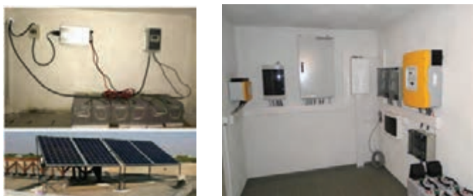
شکل ۴۶- اجرای دو نمونه سیم‌کشی سیستم فتوولتاییک
