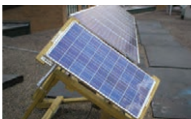
شکل ۵۳ - دو نمونه پایه و سازه پنل خورشیدی (فلزی و چوبی)
