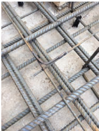
شکل ۲۱- جوش کاری میلگردها در تقاطع سه راهه
