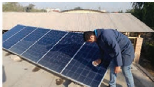
شکل ۵- تمیز کردن با پارچه نرم و آب
