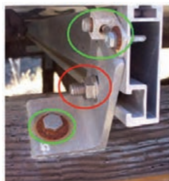
شکل ۵۶- پیچ متصل به سازه فرسوده شده است
