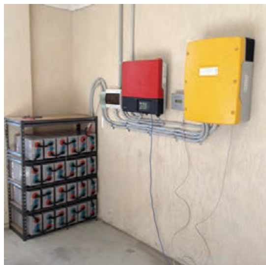
شکل ۶۱- اتصالات سیستم فتوولتائیک
