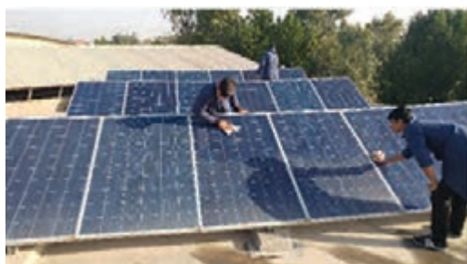
شکل ۴- تمیز کردن مدول‌های خورشیدی
