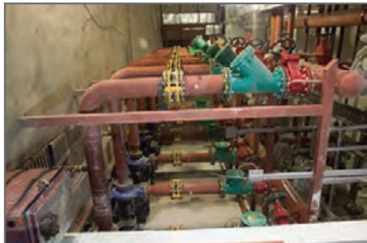
شکل ۳۳- خط مکش پمپ زمینی
