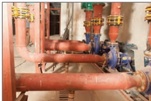
شکل ۳۳- خط مکش پمپ زمینی
