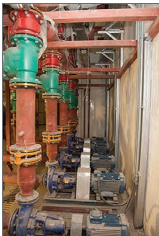
شکل ۳۲ - خط رانش پمپ زمینی
