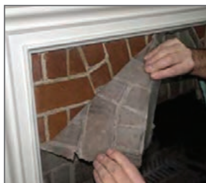
شکل ۲۱- دوده‌زدایی مکانیکی به روش برچسب پاک کننده
