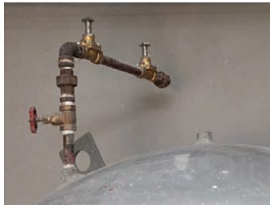
شکل ۲۳- اتصال لوله هواگیری مخزن
