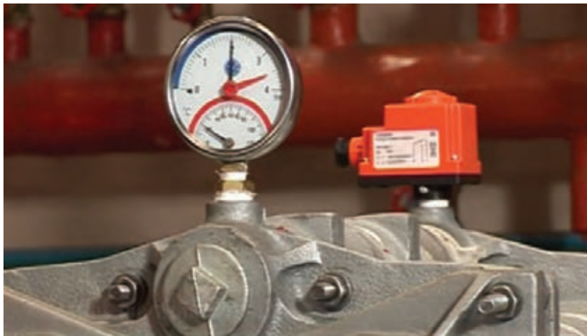
شکل ۲۱- نصب کنترل کننده و نشان دهنده دیگ
