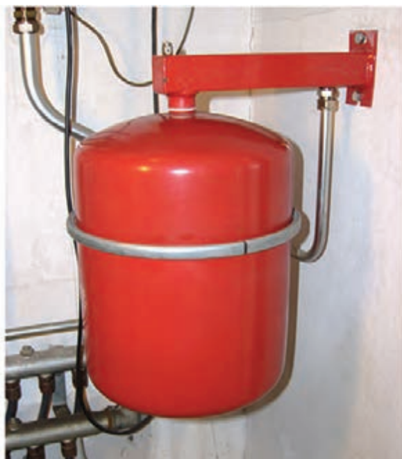
شکل ۱۶- استقرار مخزن انبساط بسته
