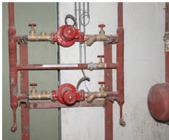
شکل ۲۴- اتصال شیر تخلیه
