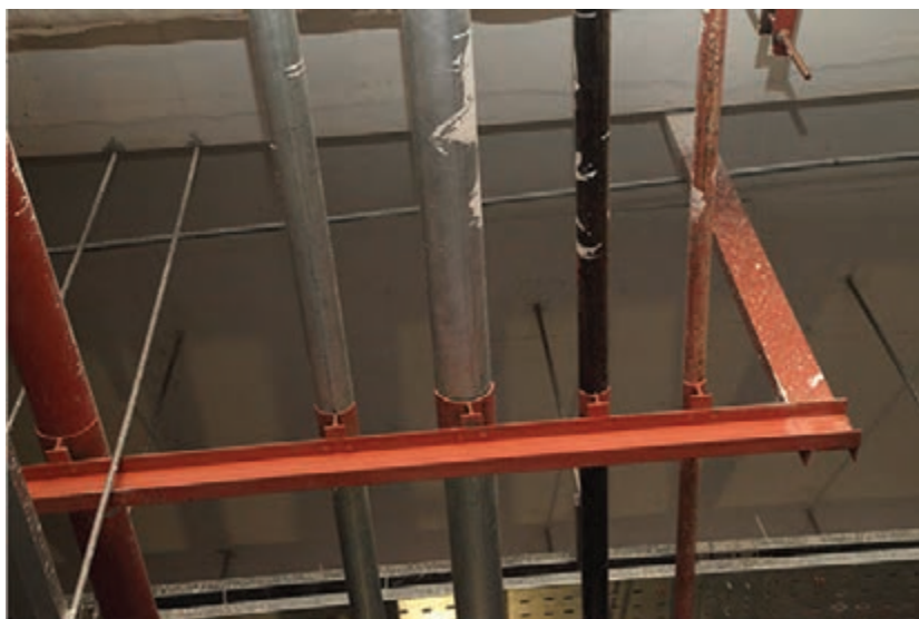
شکل ۱۶- آویز چند لوله ای
