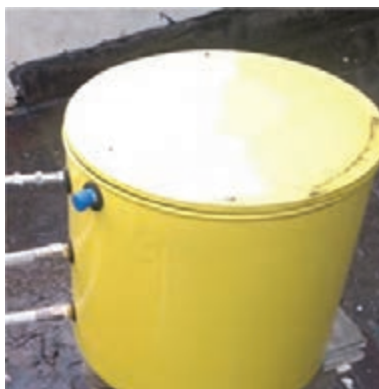
شکل ۳- مخزن انبساط باز با عایق
