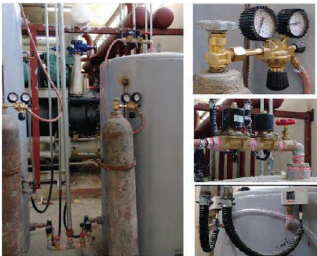
شکل ۲۳- مخزن انبساط بسته با متعلقات
