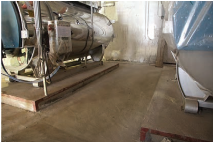
شکل ۱۴ - نصب دیگ روی فونداسیون
