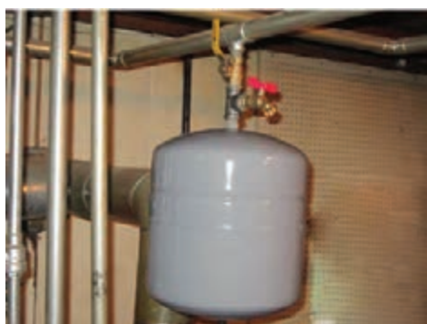
شکل ۲- مخزن انبساط بسته
