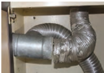
شکل ۵- روش های مختلف گازگرفتگی و لوله ناایمن
