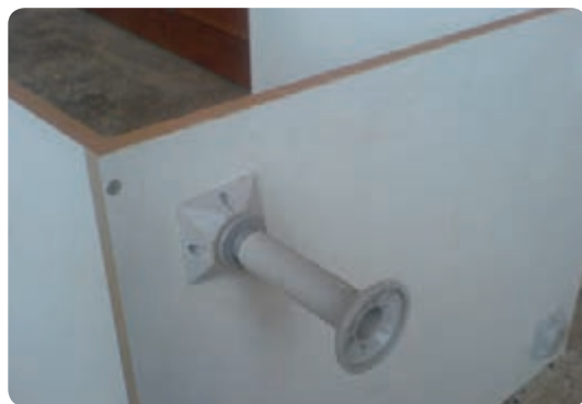
شکل ۱۱۵-۶ پایه نصب شده زیر کابینت
