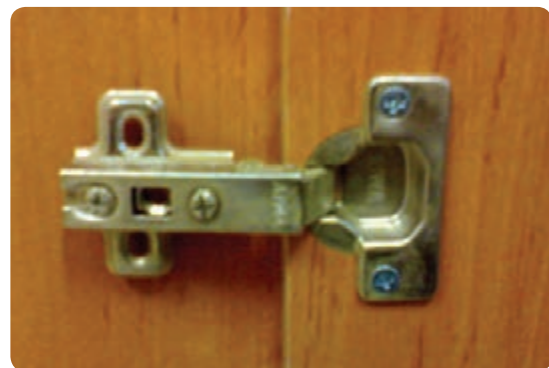
شکل ۶-۸۵ نصب کاسه لولا روی در کابینت
