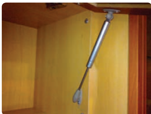
شکل ۶-۳۶ در کابینت با درجه یا نگه‌دارنده پمپی
