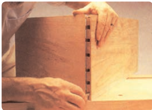
شکل ۶-۱۴۰ مونتاژ آزمایشی قبل از چسب زدن قطعات
