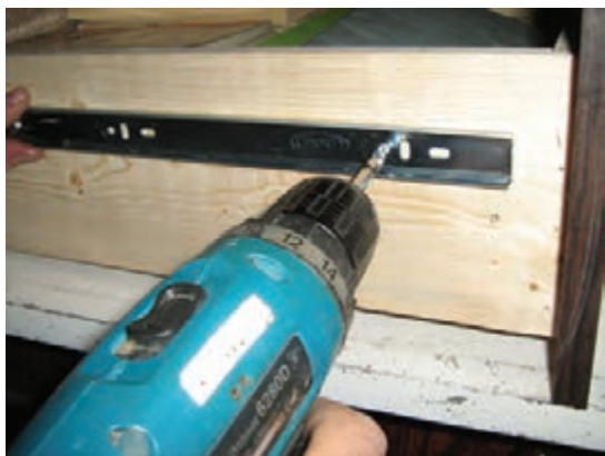
شکل ۷-۳۶ نصب ریل بر روی بدنه‌ی کشو
