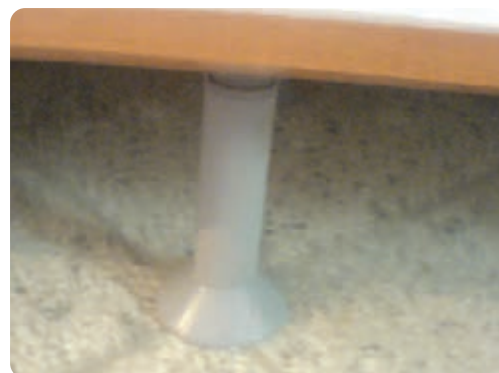
شکل ۶-۶۴ پایه نصب شده در زیر کابینت
