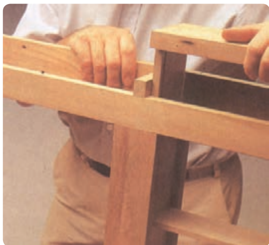
شکل ۶-۱۵۷ اطمینان از گونیی قاب
