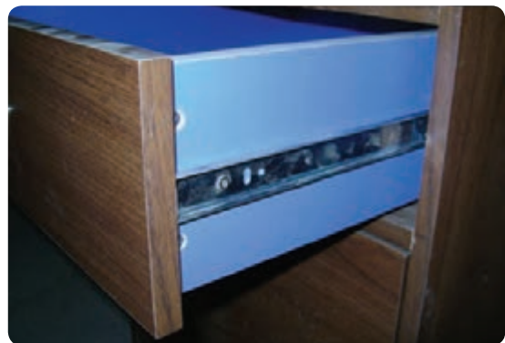
شکل ۵۶-۶ ریل مکانیکی نصب شده در بدنه جعبه
