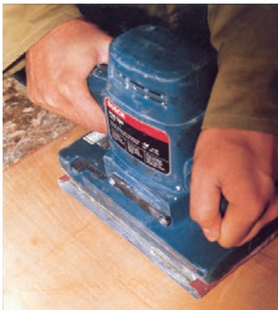
شکل ۷-۱۱. سنباده کاری در جهت الیاف.
