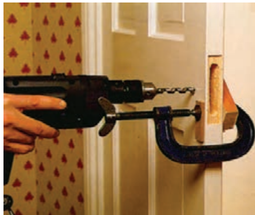
شکل ۱۰-۴۸- سوراخ‌کاری ممل پلاک و دستگیره‌ی قفل.
