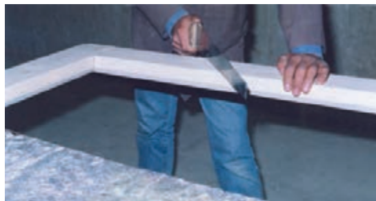
شکل ۱۱-۲۶- ایجاد شیار با اره‌ی دستی.
