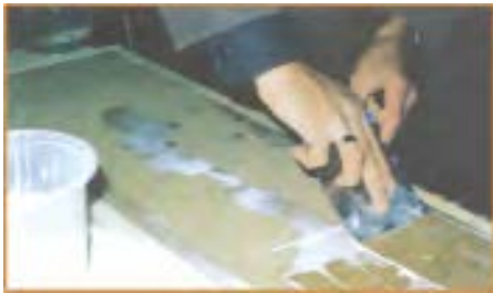
شکل ۵-۳۲. نمونه‌ی پخش کردن چسب به وسیله‌ی کاردک.
