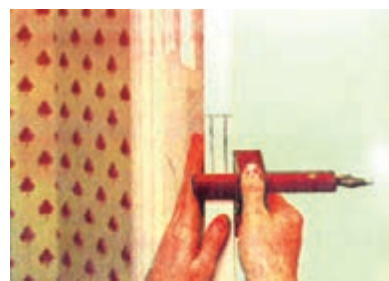
شکل ۱۰-۴۳ - فطاکشی ممل قفل با فطاکش تیره‌دار.
