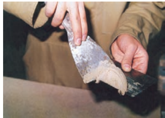
شکل ۴-۸- کاربرد لیسه و کاردک هنگام بتونه کاری.
