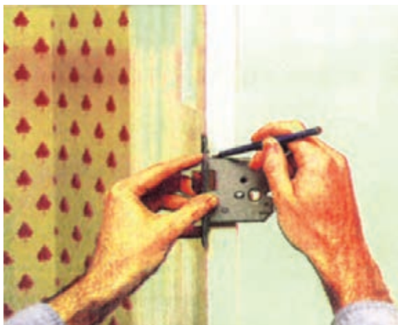
شکل ۱۰-۴۴ - فطاکشی ممل قفل (روی نر کار).
