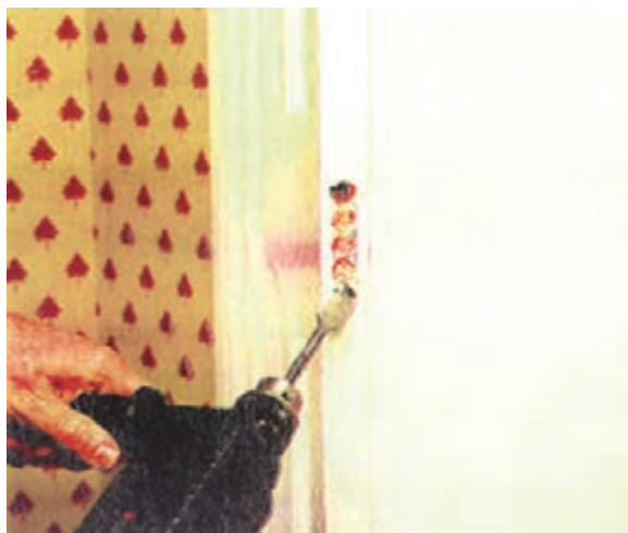
شکل ۱۰-۴۵ - تفلیهی ممل قفل با دریل.
