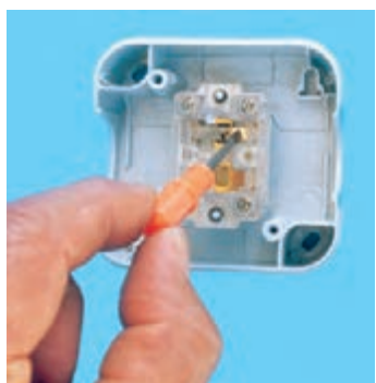
د - برقراری اتصال پلاتین با کنتاکت غیرمشترک ۲
