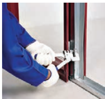
شکل ۱-۱۲۱- اتصال پایین استاد با پانچ
