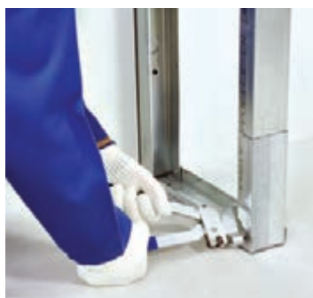
شکل ۱-۱۱۷- اتصال پایین استاد با پانچ
