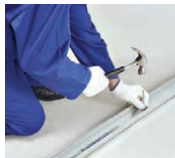
شکل ۴۲-۱- اتصال رانر به کف با رول پلاک
