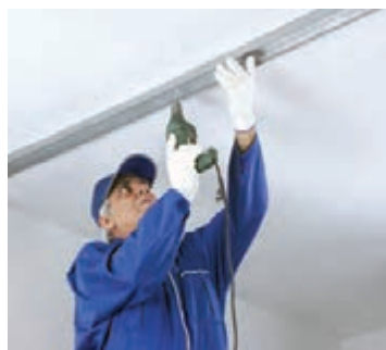
شکل ۴۸-۱ نصب رانر سقف
