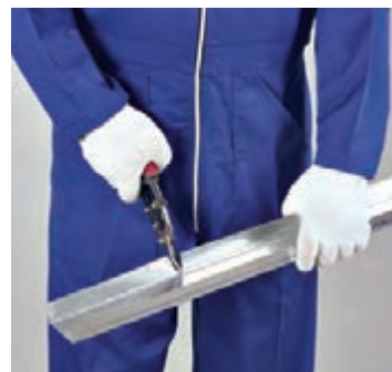
شکل ۱-۱۱۳- برش انتهای رانرهای کف
