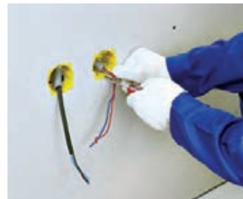
شکل ۱-۱۷۶- گیره‌ها توسط پیچ گوشتی جمع می‌شوند.
