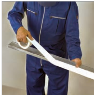
شکل ۸۵-۳- چسباندن نوار ترن فیکس بر روی سازه
