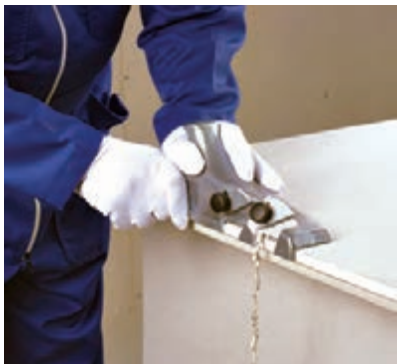
شکل ۳-۸۰ پیچ زدن
