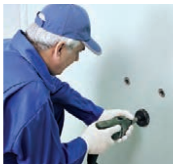
شکل ۱۰۲-۱- ایجاد خروجی تأسیسات به وسیله گرد بر
