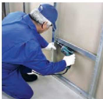
شکل ۱۶۸-۱ اتصال سازه پشتیبان به استادهای مجاور
