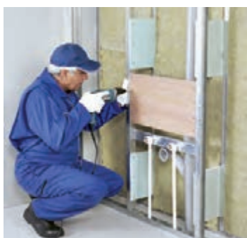
شکل ۱-۱۵۵- اتصال تراورس (تخته چند لای) به قطعات نبشی L۲۵
