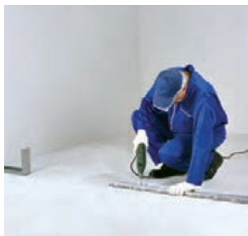
شکل ۱-۱۱۴- نصب رانر کف
