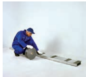
شکل ۱-۸۱- اجرای نوار عایق بر روی استادهای
