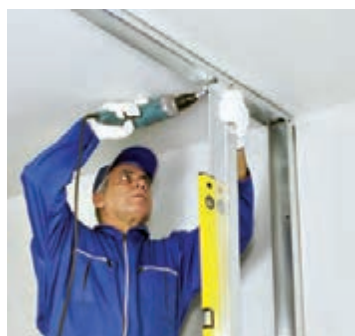
شکل ۱-۱۱۸- اتصال بالای استاد با پیچ LB
