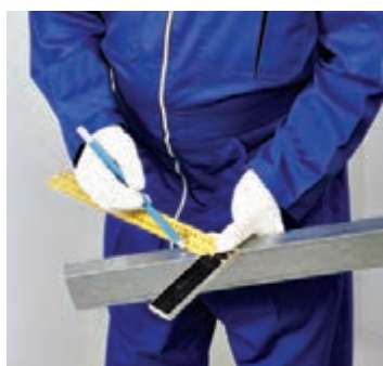
شکل ۱-۱۲۵- چهارچوب توسط پیچ LB در محل صفحات به استادهای متصل می‌شود. شکل ۱-۱۲۶- علامت‌گذاری انتهای رانر شکل ۱-۱۲۷- برش انتهای رانر نعل درگاه نعل درگاه به صورت فارسی‌بر (به اندازه ۲۰ سانتی‌متر)
