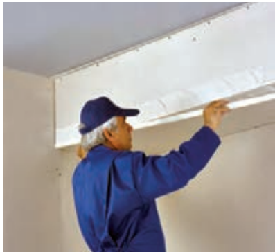
شکل ۸۴-۳- قرار دادن نوار درزگیر بر روی بتونه
