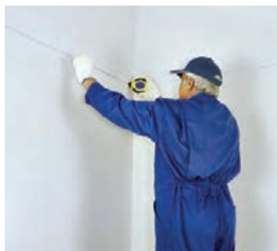
شکل ۱۰۷-۳ مشخص کردن محل نصب سازه تراز با ریسمان رنگی
