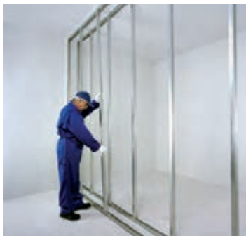
شکل ۹۶-۱: شاقولی کردن ردیف اول استادها
