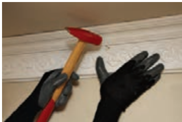
شکل ۲۴۶-۱- محکم کردن قطعه به وسیله میخ
