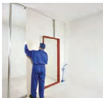
شکل ۱۳۸-۱- اجرای پانل اول دور چهارچوب
