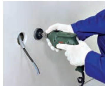
شکل ۱-۱۷۳- خروجی‌های تأسیساتی به وسیله گردبر ایجاد می‌شوند.
