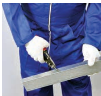
شکل ۱-۱۲۵- چهارچوب توسط پیچ LB در محل صفحات به استادهای متصل می‌شود. شکل ۱-۱۲۶- علامت‌گذاری انتهای رانر شکل ۱-۱۲۷- برش انتهای رانر نعل درگاه نعل درگاه به صورت فارسی‌بر (به اندازه ۲۰ سانتی‌متر)
