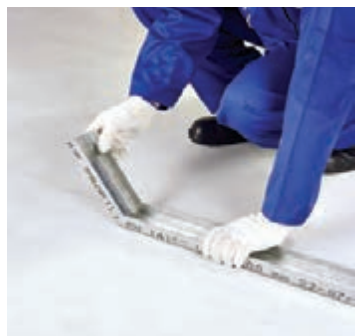
شکل ۱-۱۱۵- خم کردن انتهای رانر کف
