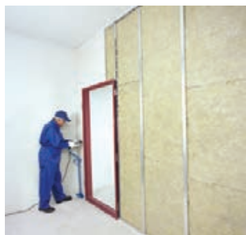
شکل ۱۴۲-۱- پیچ زنی پانل در حاشیه دور چهارچوب
