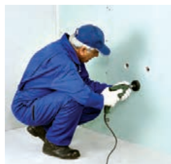
شکل ۱-۱۵۷- ایجاد خروجی‌های تأسیساتی به وسیله گردبر
