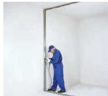
شکل ۱-۵۲- نصب استاد بر روی ساختار جانبی
