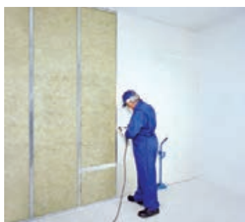
شکل ۱-۶۹- اجرای پانل‌ها در طرف دیگر دیوار
