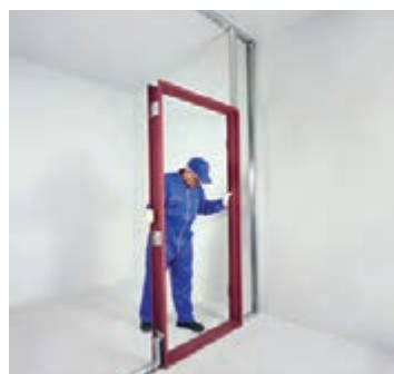
شکل ۱-۱۱۹- استقرار چهارچوب در
