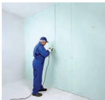
شکل ۱۰۱-۱- اجرای لایه دوم پانل‌ها
