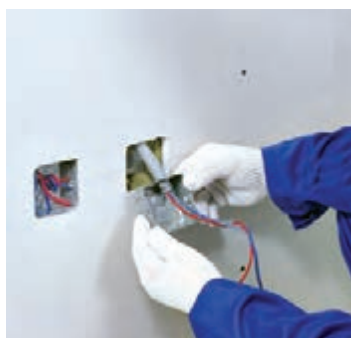
شکل ۱۷۱-۱ خروجی های تأسیساتی به وسیله اره و سوهان ایجاد می شوند (در نصب قوٹی های فلزی برق با سازه پشتیبان، برش کاری خروجی، قبل از نصب پانل صورت می گیرد)
