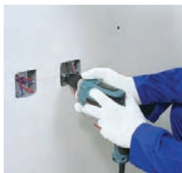
شکل ۱۷۲-۱ قوٹی برق می تواند پس از نصب پانل به سازه پشتیبان متصل شود.
