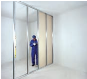
شکل ۱-۶۲- اجرای پانل‌ها در یک طرف دیوار
