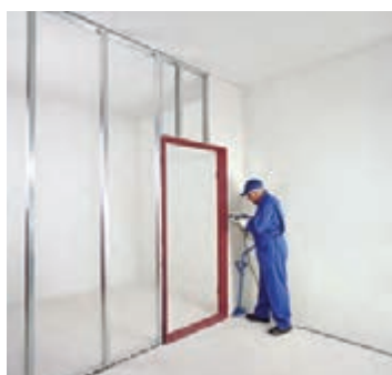
شکل ۱۳۸-۱- اجرای پانل اول دور چهارچوب
