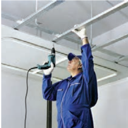
شکل ۳-۶۷ اتصال پانل به زیرسازی توسط پیچ
