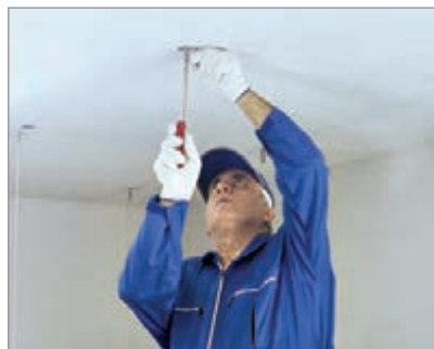
شکل ۳-۱۱۶ اتصال قطعه HT ۹۰ به سقف اصلی شکل ۳-۱۱۷
