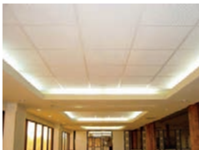
شکل ۱۱۰-۳- اجرای کامل سقف مشبک به روش قرینه‌سازی
