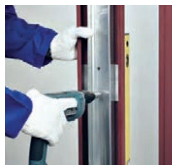
شکل ۱-۱۲۵- چهارچوب توسط پیچ LB در محل صفحات به استادهای متصل می‌شود. شکل ۱-۱۲۶- علامت‌گذاری انتهای رانر شکل ۱-۱۲۷- برش انتهای رانر نعل درگاه نعل درگاه به صورت فارسی‌بر (به اندازه ۲۰ سانتی‌متر)
