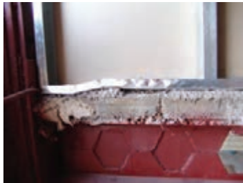
شکل ۷۱-۱. اجرای نامناسب رانر بر روی کف سازه‌ای
