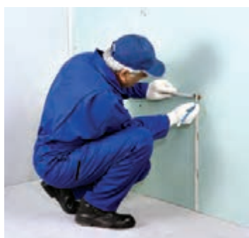
شکل ۱-۱۵۶- تعیین محل خروجی‌های تأسیساتی
