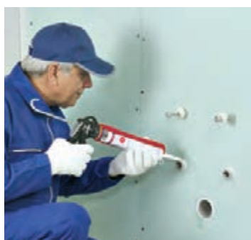
شکل ۱-۱۵۹- اجرای خمیر درزبند در اطراف خروجی‌های تأسیساتی
