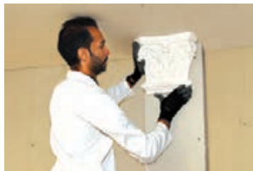
شکل ۲۴۲-۱- اتصال قطعه اول به ستون
