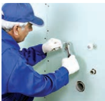
شکل ۱-۱۵۸- اتصال مهار روشویی به تراورس
