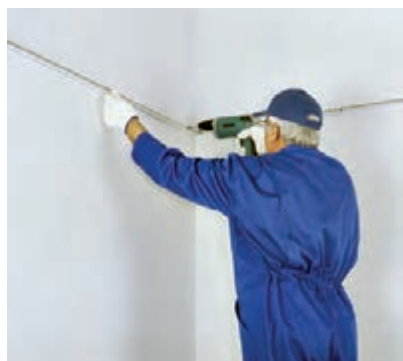
شکل ۱۰۸-۳ نصب سازه تراز پس از تعیین خط تراز سقف
