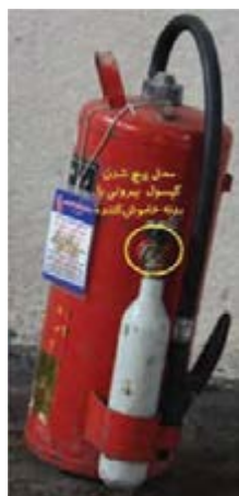
شکل ۹-۳ خاموش کننده پودر و گاز فشنگ خارج
