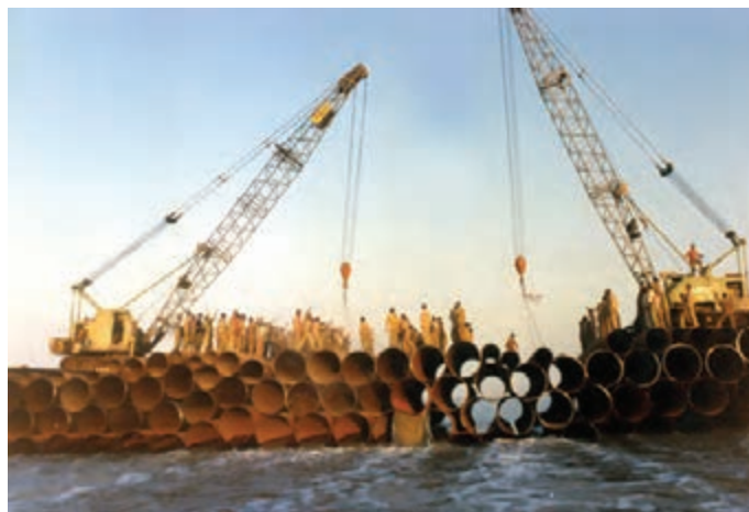
شکل ۱۱-۵- پل بعثت در حال ساخت
