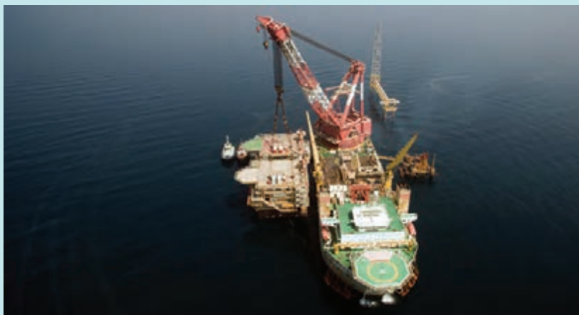
عملیات نصب سکوی فاز ۱۹ پارس جنوبی در خلیج همیشه فارس با به کارگیری از یکی از مدرن ترین شناورهای نصاب منطقه (اوشنیک ۵۰۰۰)
