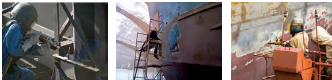
شکل ۱-۷- زنگ‌زدایی در اسکله خشک
