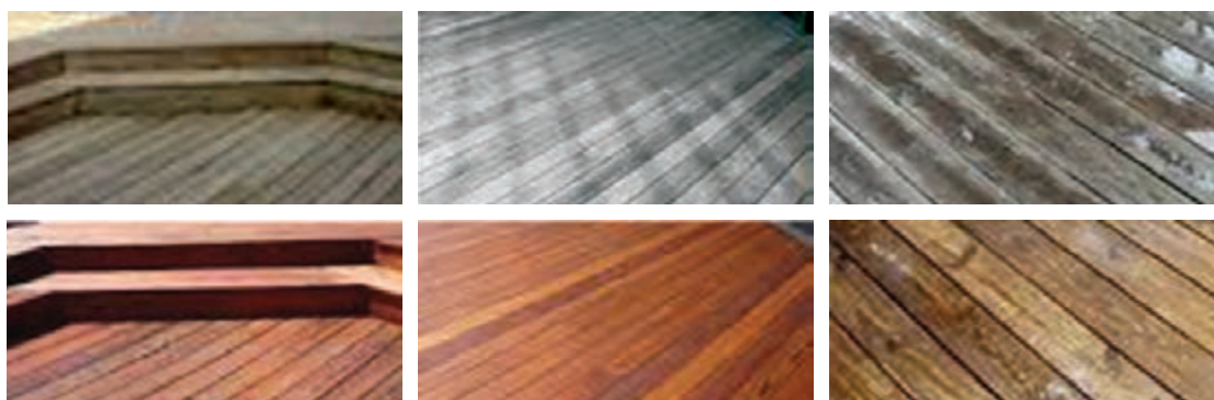
شکل ۱۰-۱- فرسایش چوب (ردیف بالا) و پس از لایه‌برداری (ردیف پایین)
