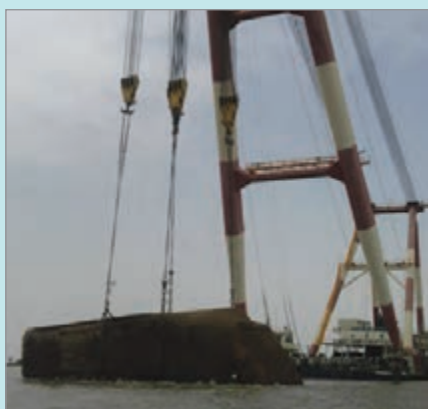
عملیات خارج سازی شناور «کارون بار» با استفاده از جرثقیل شناور از قعر آب های اروندرود
