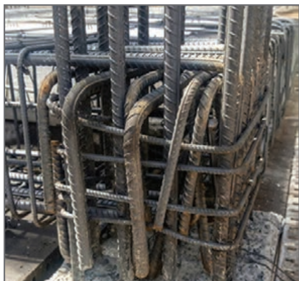
شکل ۵۶ - خطای اجرایی : عبور خم انتهایی آرماتور تیرها از آرماتورهای عرضی ستون
