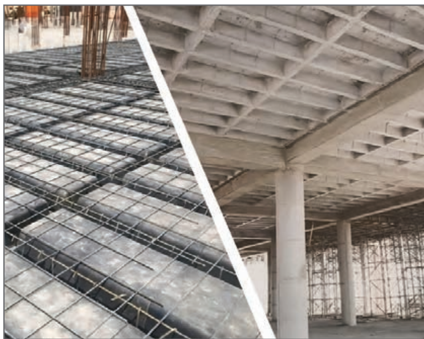
شکل ۲۴- سقف وافل با تیرچه‌های یک طرفه
