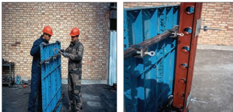
شکل ۱۹- کاربرد بولت عصایی و نحوه اتصال آن در مقطع بتنی
