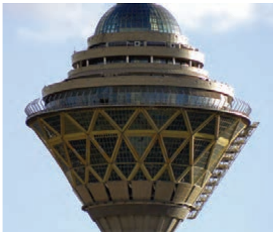
شکل ۲- سازه فلزی برج میلاد تهران
