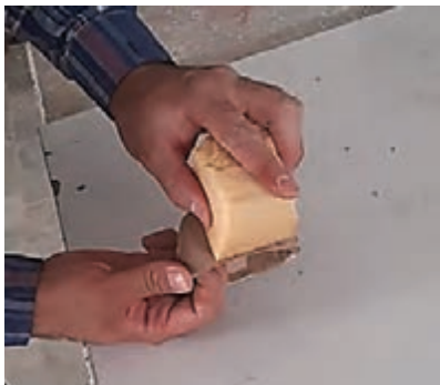
شکل ۱۵- صاف و یکنواخت کردن سطوح با ابر مرطوب
