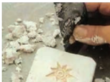
شکل ۱۰- تراشیدن قالب گچی
