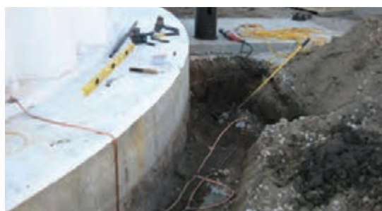
شکل ۲۶- تخلیه الکتریسیته ساکن بدنه مخزن به زمین
