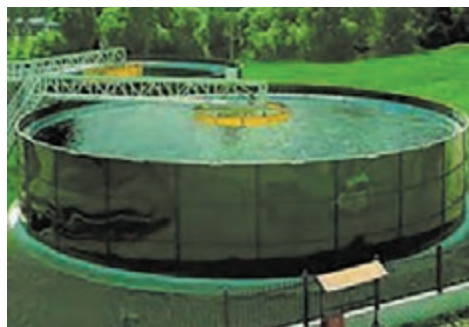
شکل ۱۴- مخزن ذخیره‌سازی بدون سقف
