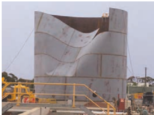
شکل ۲۸- آسیب دیدن مخزن به دلیل وزش باد
