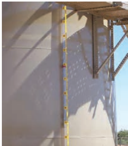
شکل ۲۳- ارتفاع سنج مغناطیسی روی مخزن
