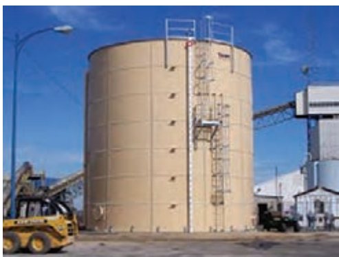
شکل ۳- اندازه‌گیری ارتفاع سطح سیال با استفاده از سطح‌سنج در تانک ذخیره
