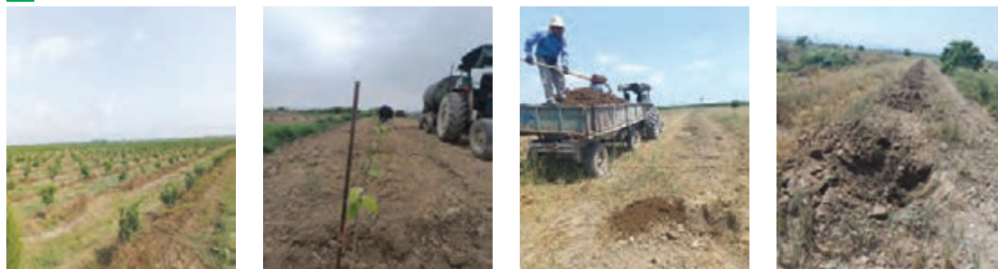
شکل ۶۸- مراحل مختلف احداث باغ (حفر گودال، پخش کود حیوانی، کاشت نهال و آبیاری، باغ احداث شده)
